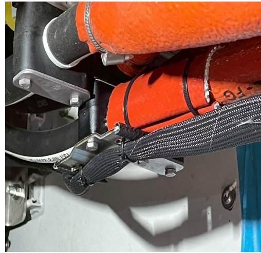
圖 2-13-5 R230 引擎室油管保護套破損 (After)
