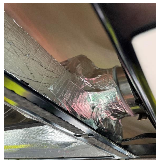
圖 2-6-7 R229 後端冷氣天花板加裝隔熱材質
