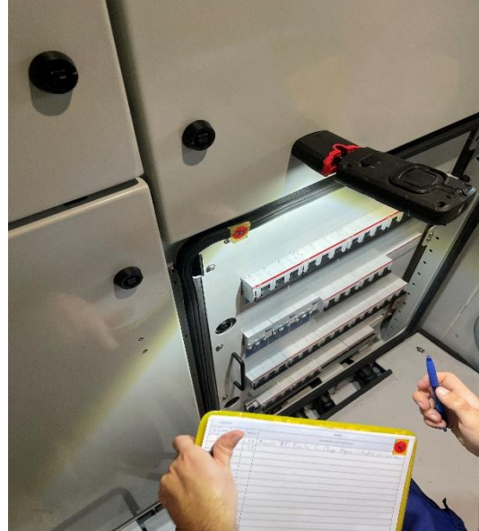
圖 2-12-2 R230 電器室右下電器箱膠條脫落未裝妥
