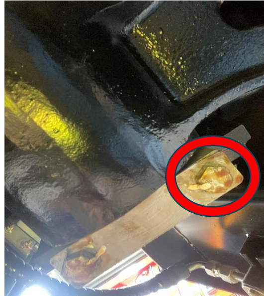
圖 2-13-2 R230 左側第三軸防動壓片未固定
