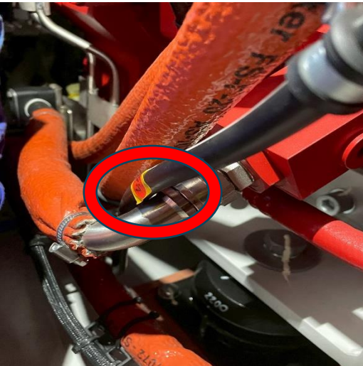
圖 2-13-6 R230 引擎室線路與油管干涉 (Before)
