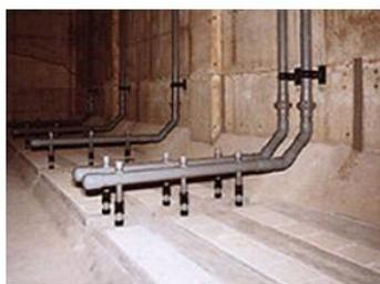
散氣板(旋回流式) 酸素移動効率 14~16%
