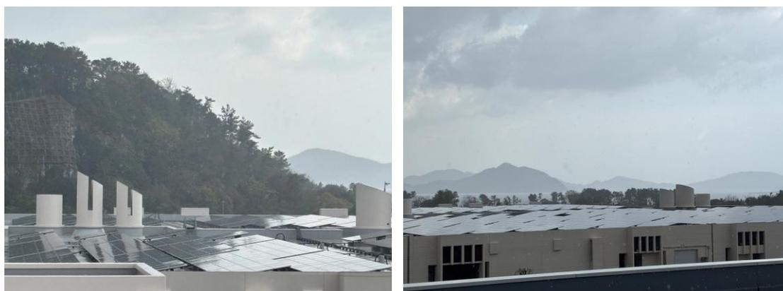
圖 3.27 西部水處理中心利用場內屋頂之空間設置大規模的太陽能發電站
