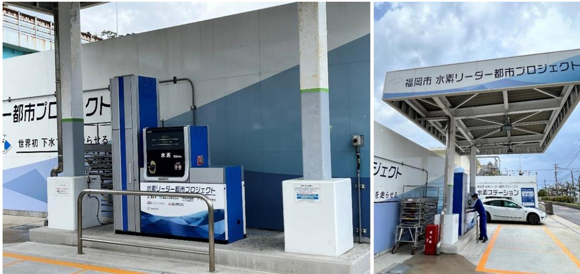
圖 3.19 福岡中部污水處理廠的氫能車加氫站
