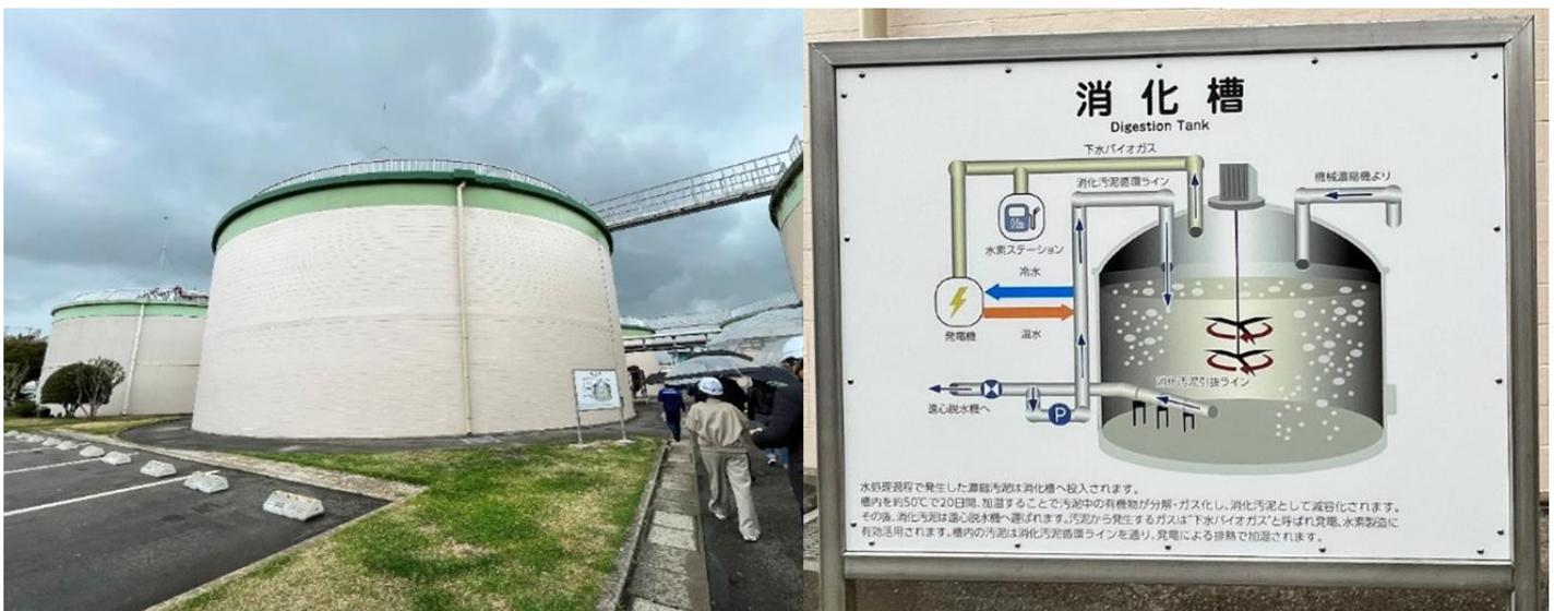
圖 3.20 福岡中部污處理廠污泥消化槽及運作說明
