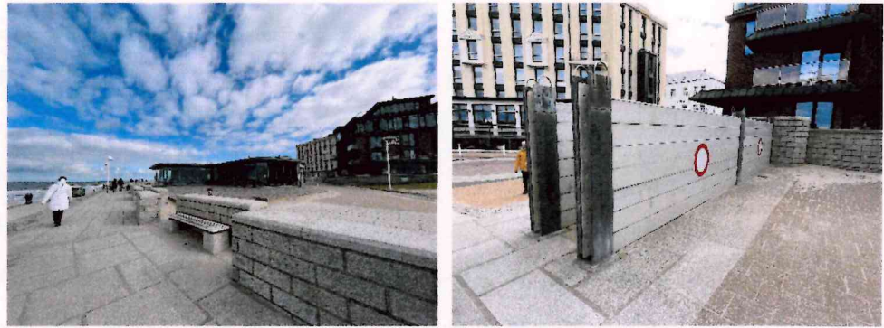
圖 19 消波及禦潮設施
