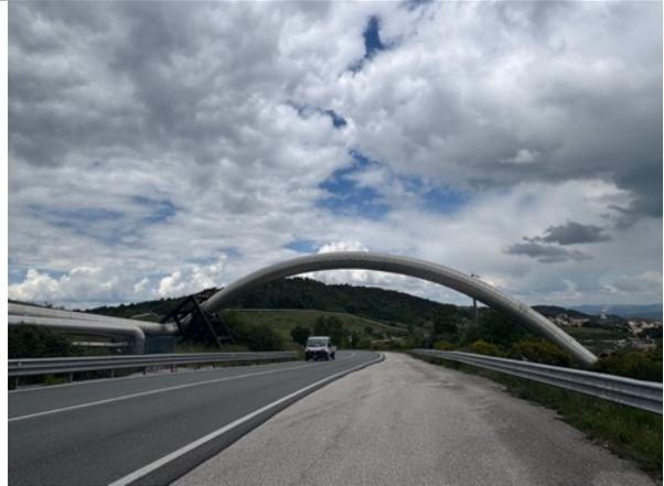
圖 52 拉岱洛常見越過道路高架的地熱蒸汽管線。
