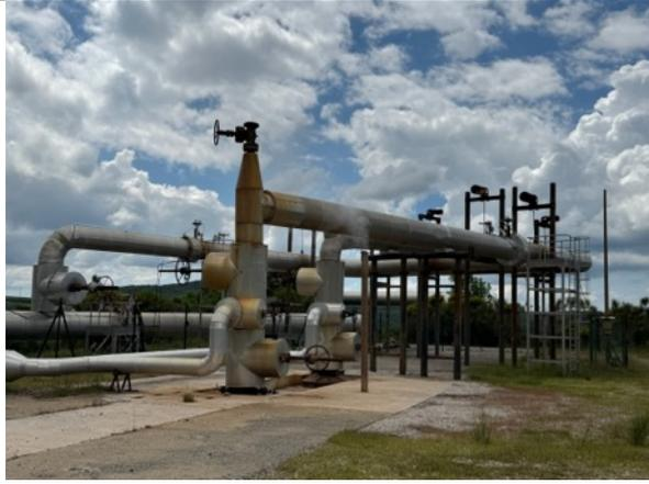
圖 51 穩定蒸汽的地熱生產井。
