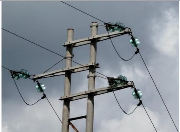
圖 66 園區電力設施的絕緣構件改以玻璃製成，以抵抗硫化氣體造成的腐蝕性損害。
