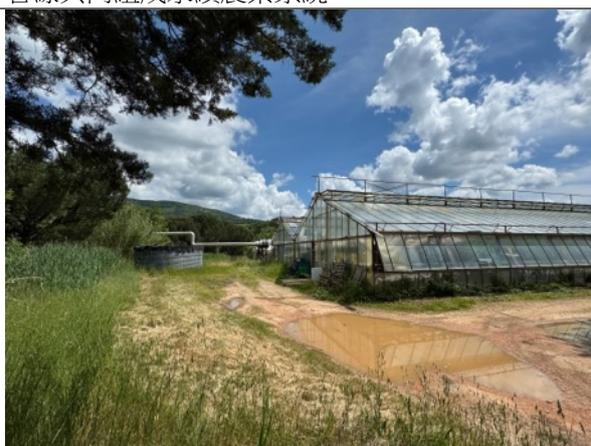
圖 70 農場中的蒸汽管道系統在熱能循環後轉為冷凝水，集中於水槽回收再利用。
