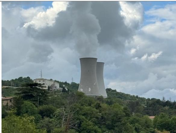
圖 47 拉岱洛地熱發電廠均採用乾蒸汽型發電，供應穩定高壓熱蒸汽。
