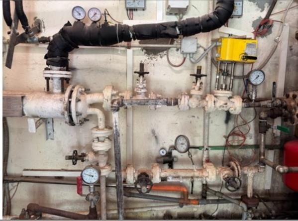
圖 57 地熱井蒸汽系統連接至廠區，配備溫度與壓力監測儀器，維持釀造穩定性。
