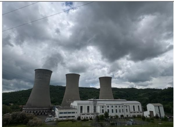
圖 50 發電廠設有 60 MW 發電機組與混合冷卻塔，提升能源效率與環境適應性。
