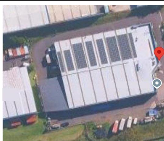
圖6、進口業者倉庫
