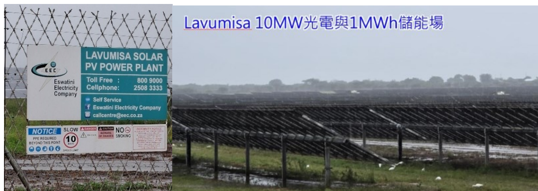
圖 2.2.8 Lavumisa 太陽光電與儲能場
