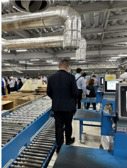
圖 46、工作站設置專用風管
