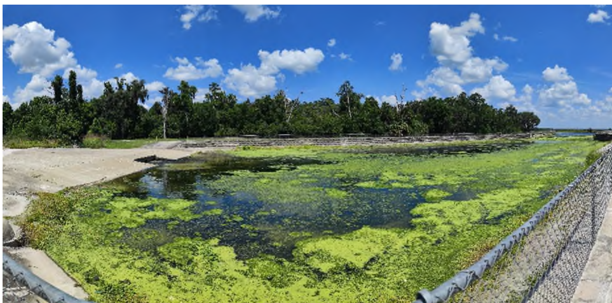
圖 8-3 Sweetwater 濕地公園沉澱池
