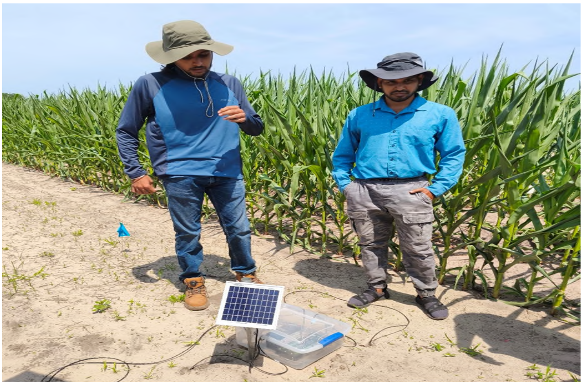
圖 6-8 太陽能土壤感測設備
