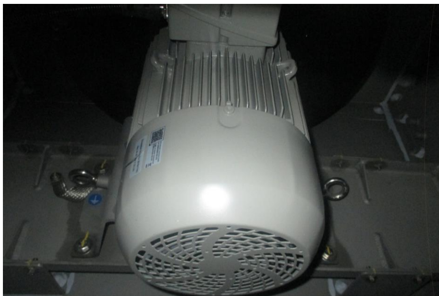
圖 6-5-12 冷卻塔內部風扇馬達
