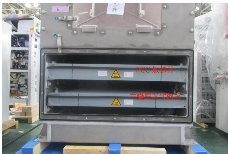
圖 6-5-14 PCC 散熱器與主變壓器散熱器
