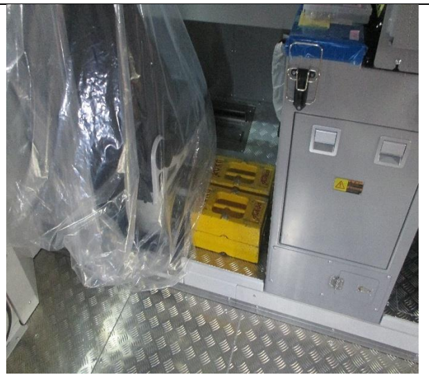
圖 3-3.12 配重塊放置（駕駛室）
