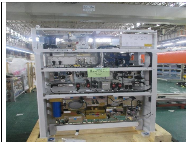
圖 3-1.3 C 工程：機械室機器裝設組裝
