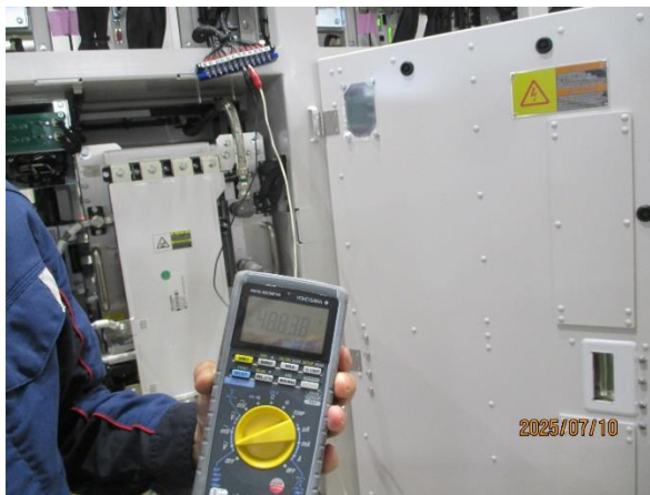
圖 3-6-2-9 確認接點輸出電壓
