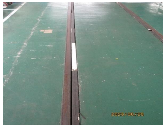
圖 5-3 軌道間隙填充後地面平整
