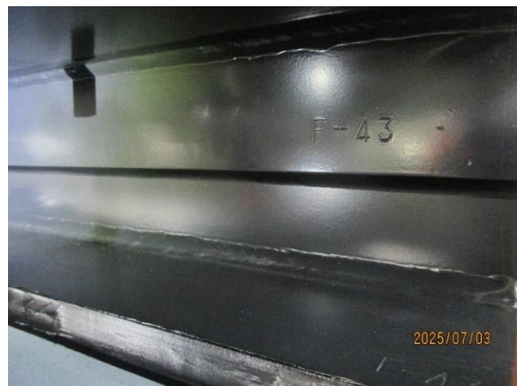
圖 3-4-2-4 檢視 E543 車架結構塗裝
