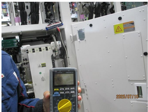
圖 3-6-2-10 確認接點輸出電壓
