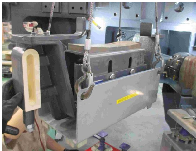
圖 4-3-11-8 (連結器支撐座吊掛(1))
