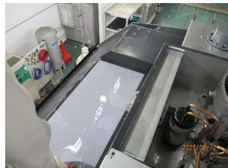
圖 3-6-3-8 檢查排水孔排水情形
