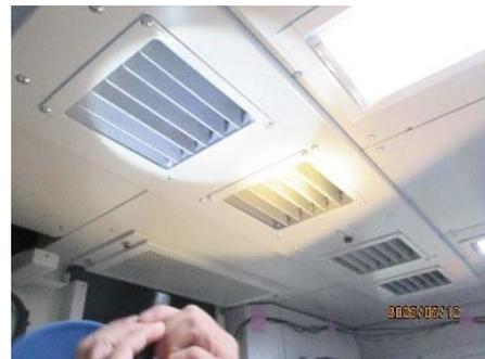
圖 3-6-3-6 檢查 SA 出風口是否漏水
