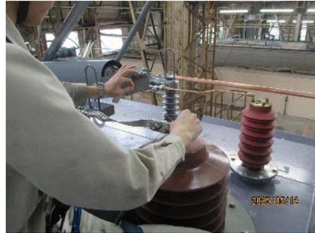
圖 3-4-4-4 使用棉繩量測是否有導電零件
