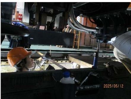
圖 3-5-5-3 量測 CAU 之 Z 的尺寸
