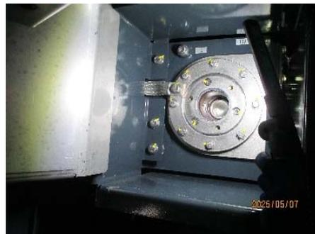
圖 3-4-4-8 檢查主變壓器與高壓穿套連結裝置之防水功能
