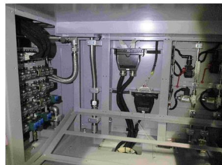
圖 3-37:駕駛室及機械室配線作業
