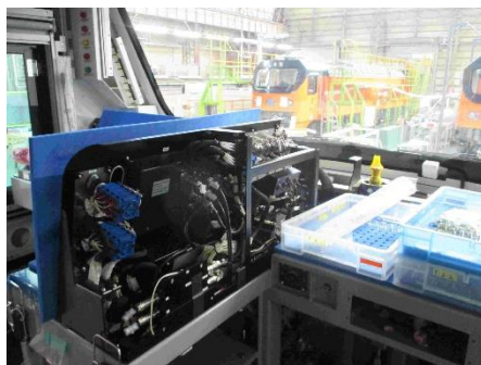
圖 3-36:駕駛室及機械室配線作業
