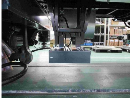
圖 3-33:車上及車下設備安裝工程
