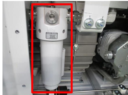
圖 4-2-1-17 下壓縮機水分離器
