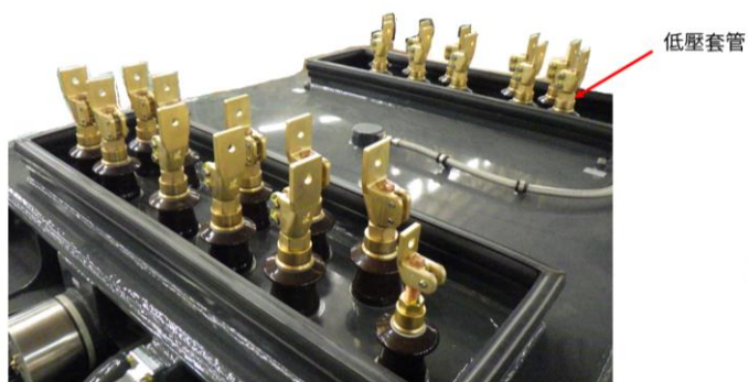
圖 4-3-3-6 低壓套管
