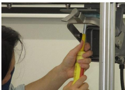
圖 4-5-5-19 絕緣管安裝實作
