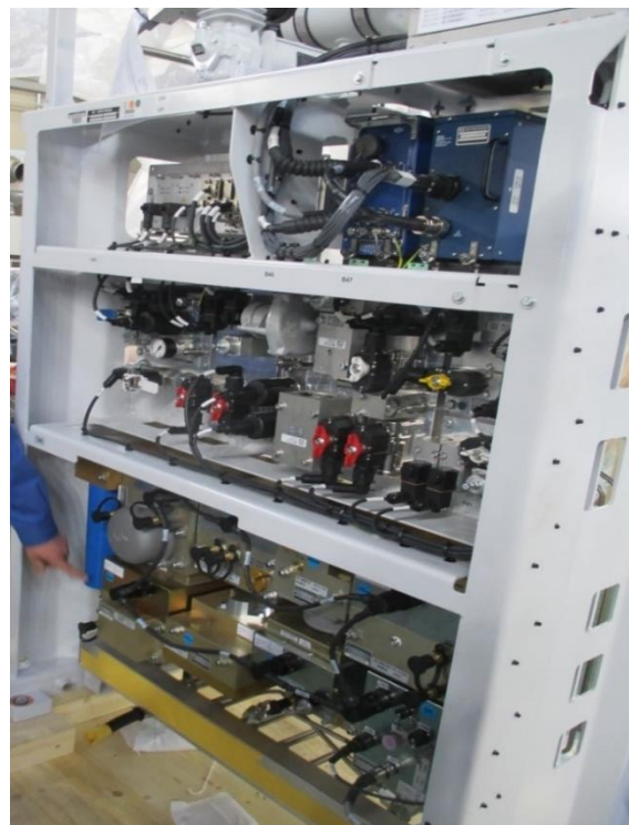
圖 4-4-1-2 軔機控制系統
