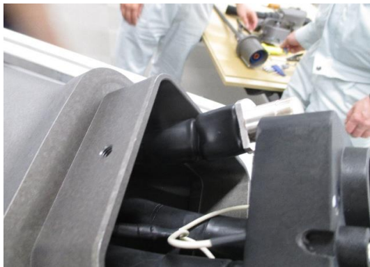
圖 4-5-5-32 熱縮套管實作
