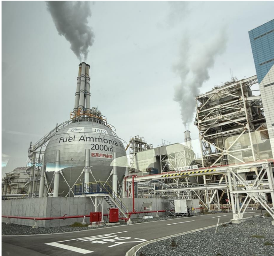
圖 7 JERA 碧南發電廠儲氨槽
