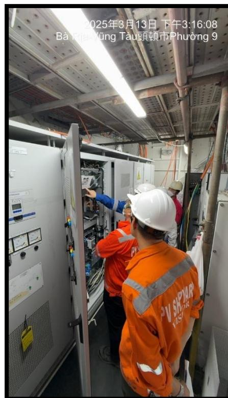
圖 20 230V AC UPS 設備測試
