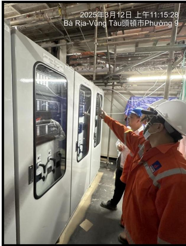
圖 11 C&P 盤體測試
