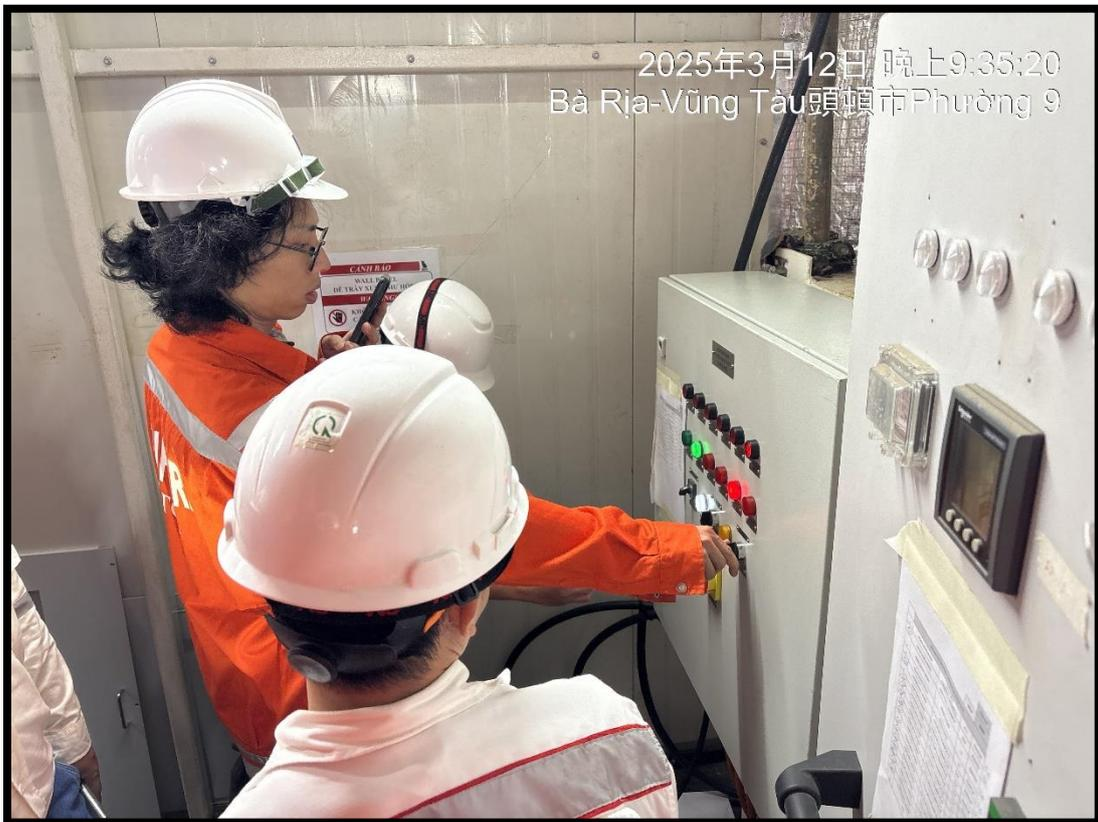
圖 16 直升機平台照明開關控制測試
