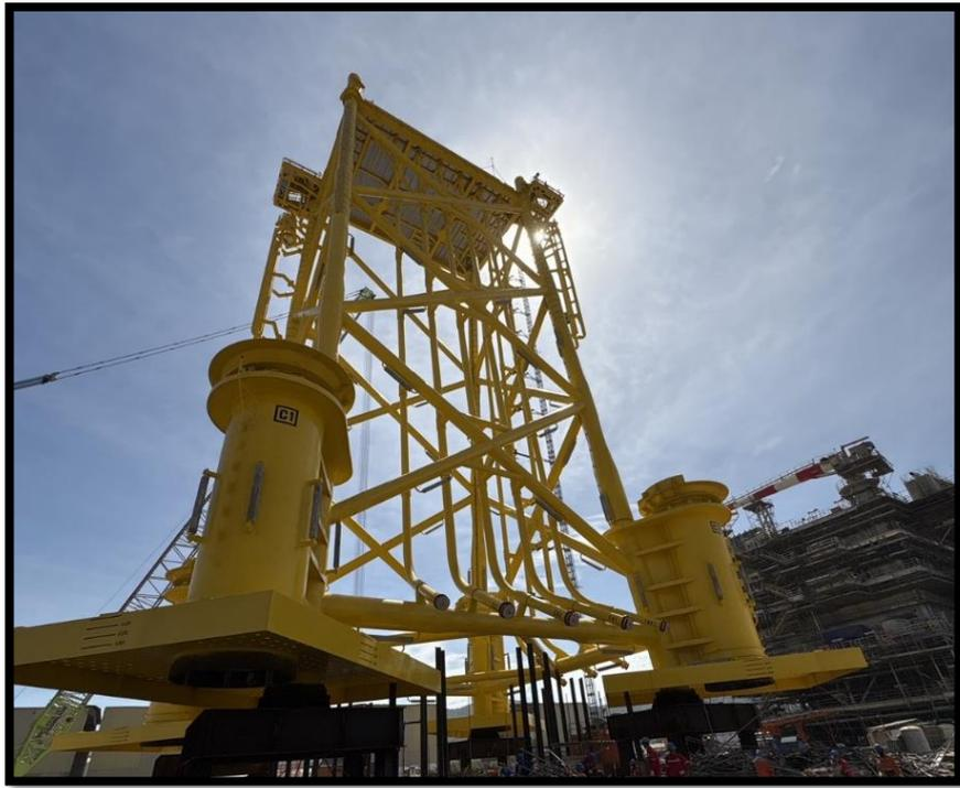
圖 4 海上變電站下部結構製造現況（套筒桁架）
