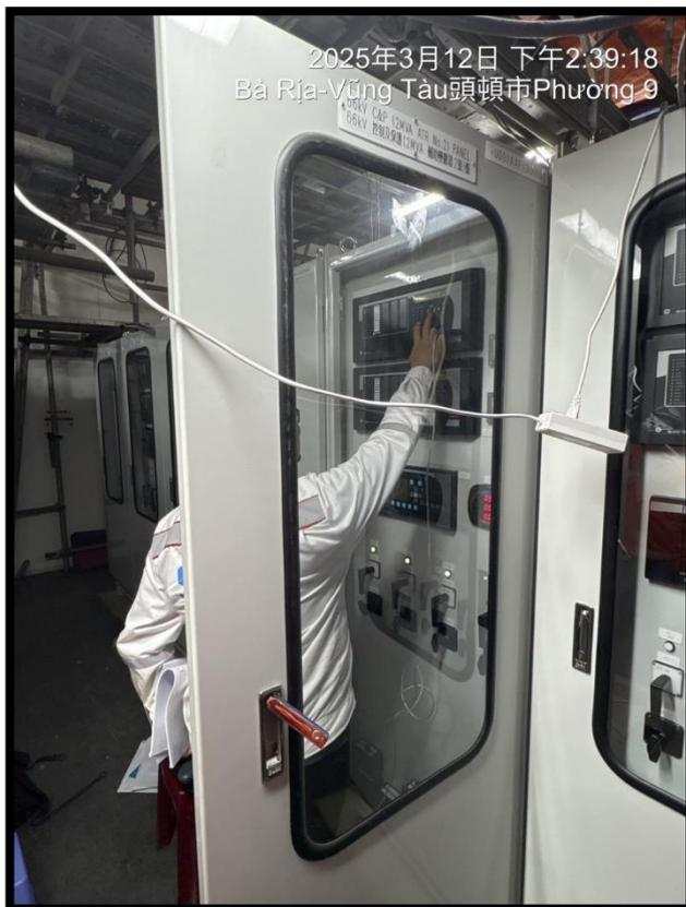
圖 12 模擬 C&P 盤體跳脫及實際動作測試
