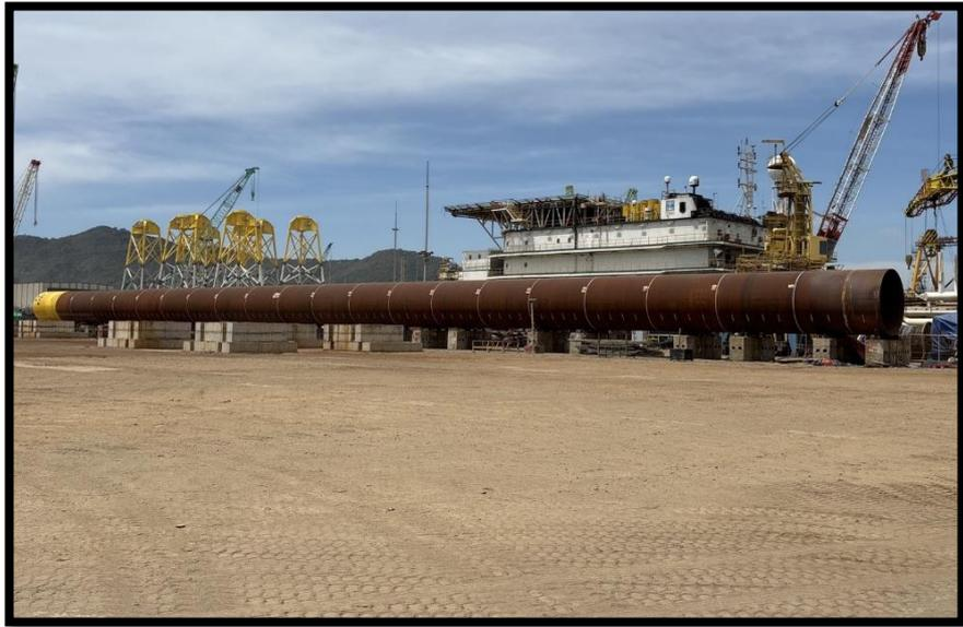
圖 3 海上變電站下部結構製造現況（1 支鋼管樁於碼頭邊）
