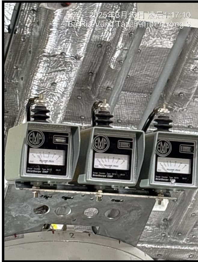
圖 19 SA 設備(R 相)測試
