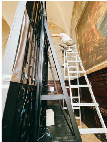
▲展品「光明燈牆」木作及鋼骨結構組裝
