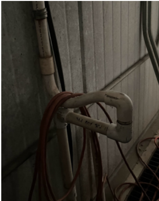
(a)排水管設計U型彎曲，讓部分水滯留於管內，維持庫內氣體濃度。
