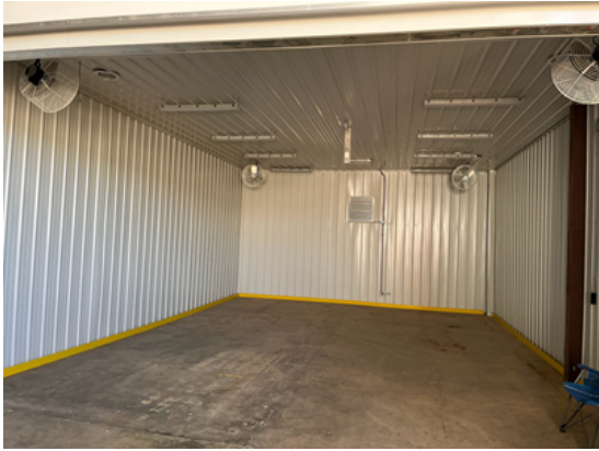
(c) 貯藏庫內有排風扇(夜間開窗通風降溫)及循環扇對流空氣。
