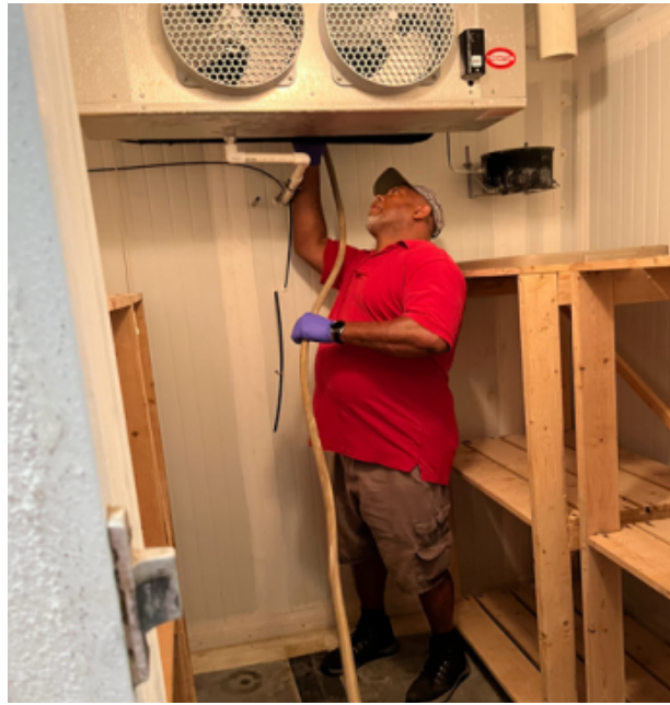
(a)排水管設計U型彎曲，讓部分水滯留於管內，維持庫內氣體濃度。
