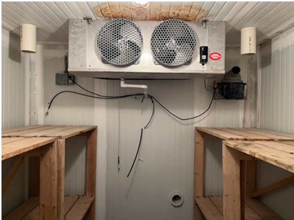
(a)庫內為側吸氣冷式蒸發器。
