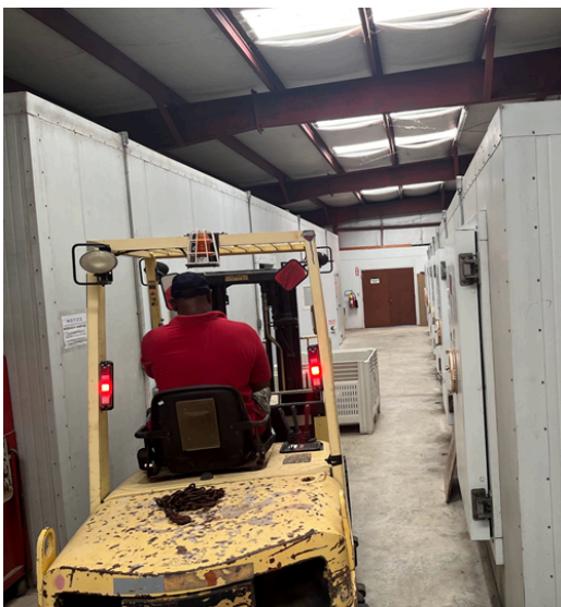
(a)走道設計寬，堆高機或拖板車可搬運棧板。
