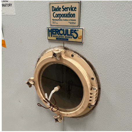
(d)小型氣調貯藏庫庫門設置氣體取樣孔。
