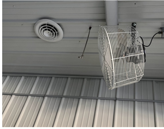
(d) 循環扇前方有加濕器及冷/熱空調出風口。
