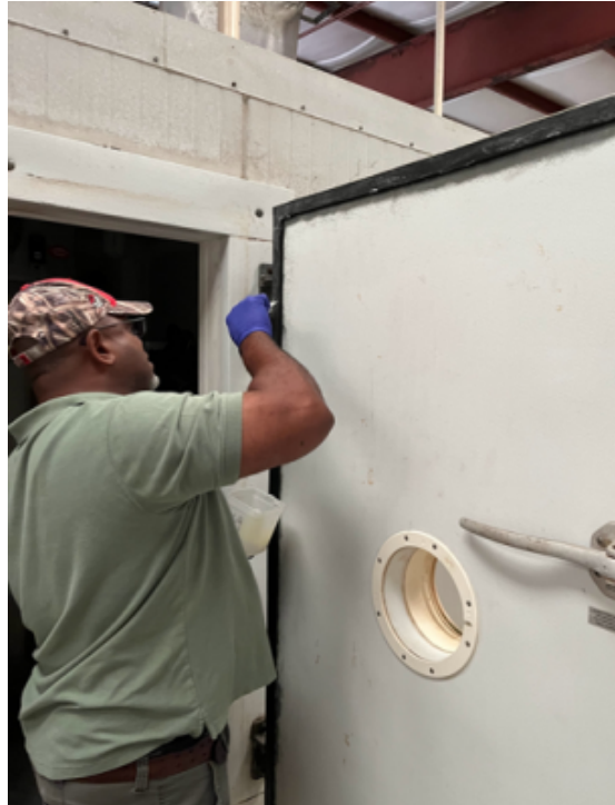
(b) 若庫門氣密性不佳，可先於門框塗上石蠟 (Petrolatum) 阻隔空氣。
