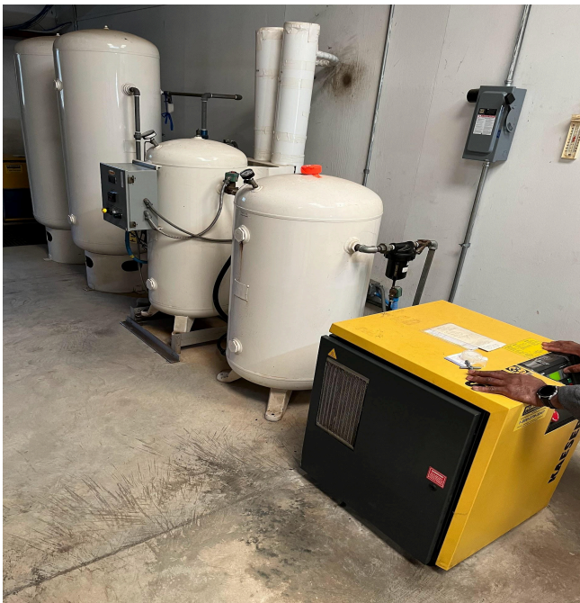
圖6. 氮氣產生器，由圖右至左分別為空壓機、高壓空氣貯存桶、氣體分流器（含濾心及氣體貯存桶）、空氣貯存桶及氮氣貯存桶。
