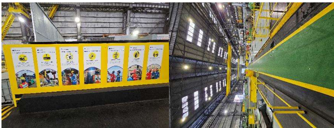
4.機艙及甲板地板都有鋪塑膠布減少對於船上地板汙染
