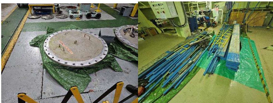
4.機艙及甲板地板都有鋪塑膠布減少對於船上地板汙染
