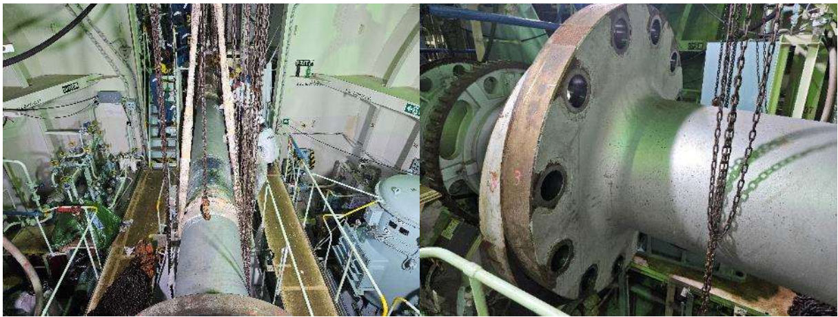
尾軸抽軸作業
