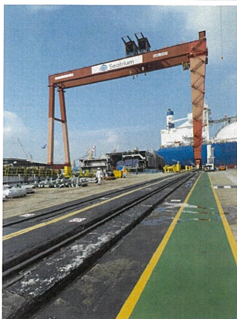
塢修用大型滑軌移動式吊臂
