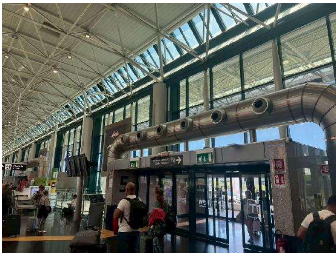
圖 4.44 航廈出風口採工業風裸露設計
