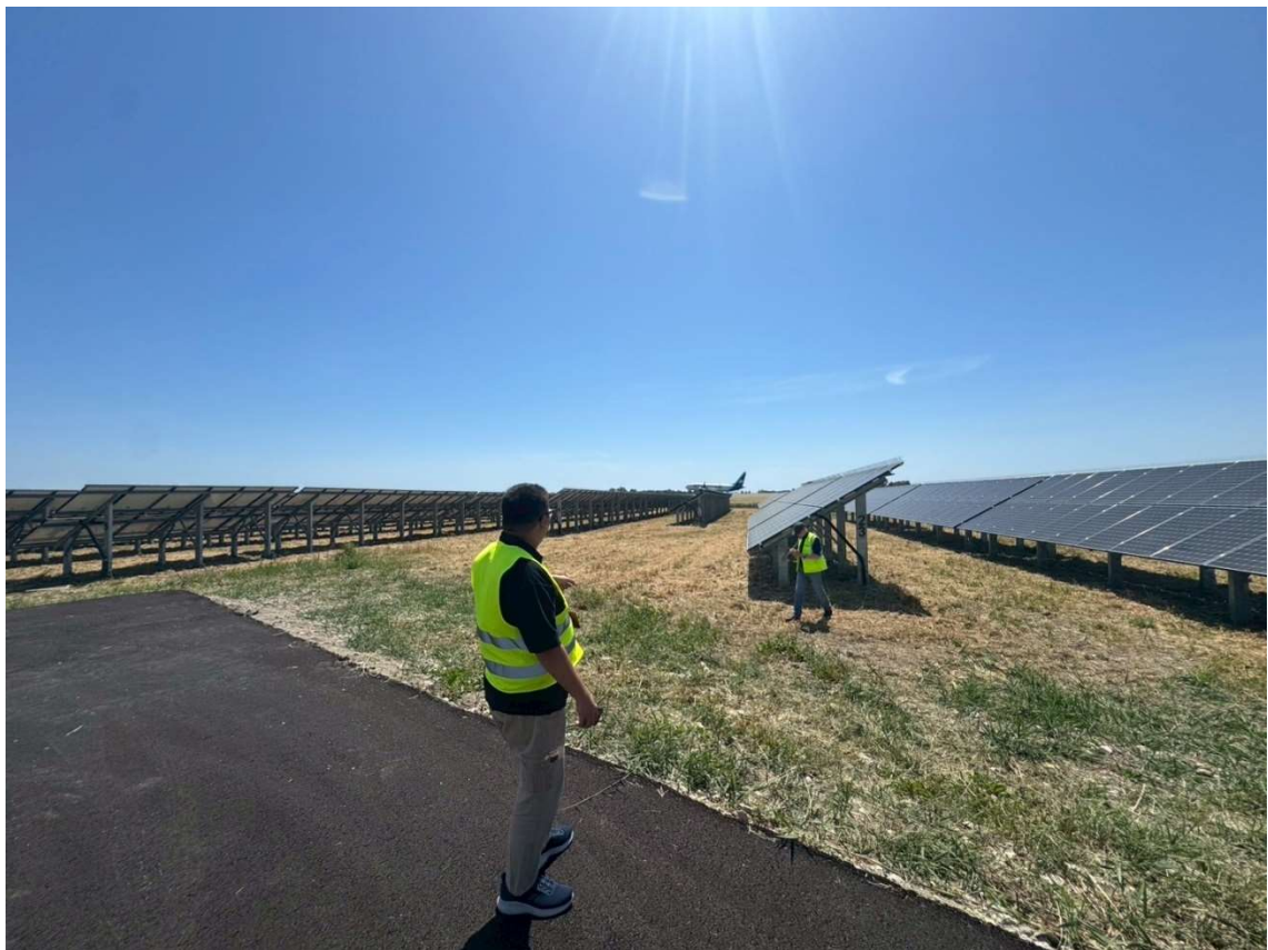
圖 6.10 太陽能板設置緊鄰跑道，惟高度略低於跑道
