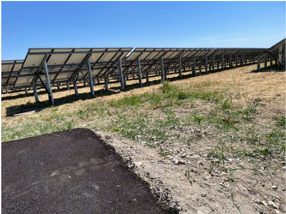
圖 6.9 太陽能板設置高度仍能容納 1 人身高
