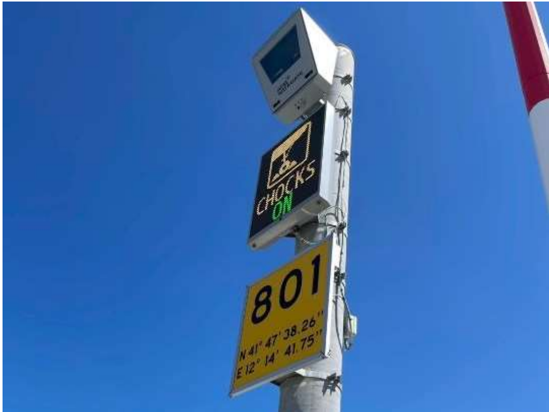
圖 3.33 第二代先進目視導引系統飛機停妥架輪檔提醒畫面
