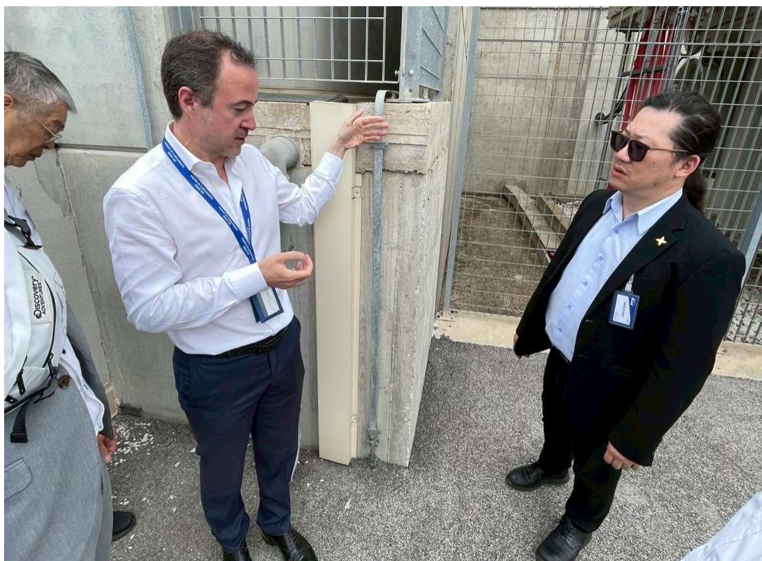
圖 5.9 避雷設備為設置法拉第籠方式
