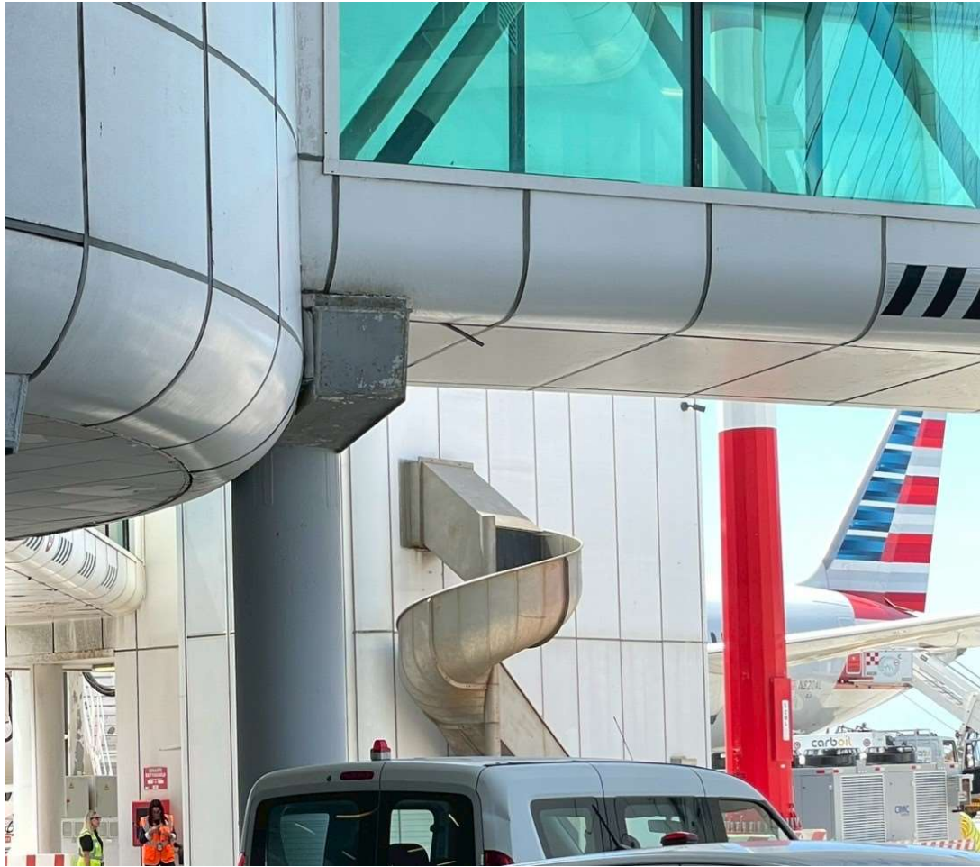
圖 3.27 固定空橋逃生溜滑梯
