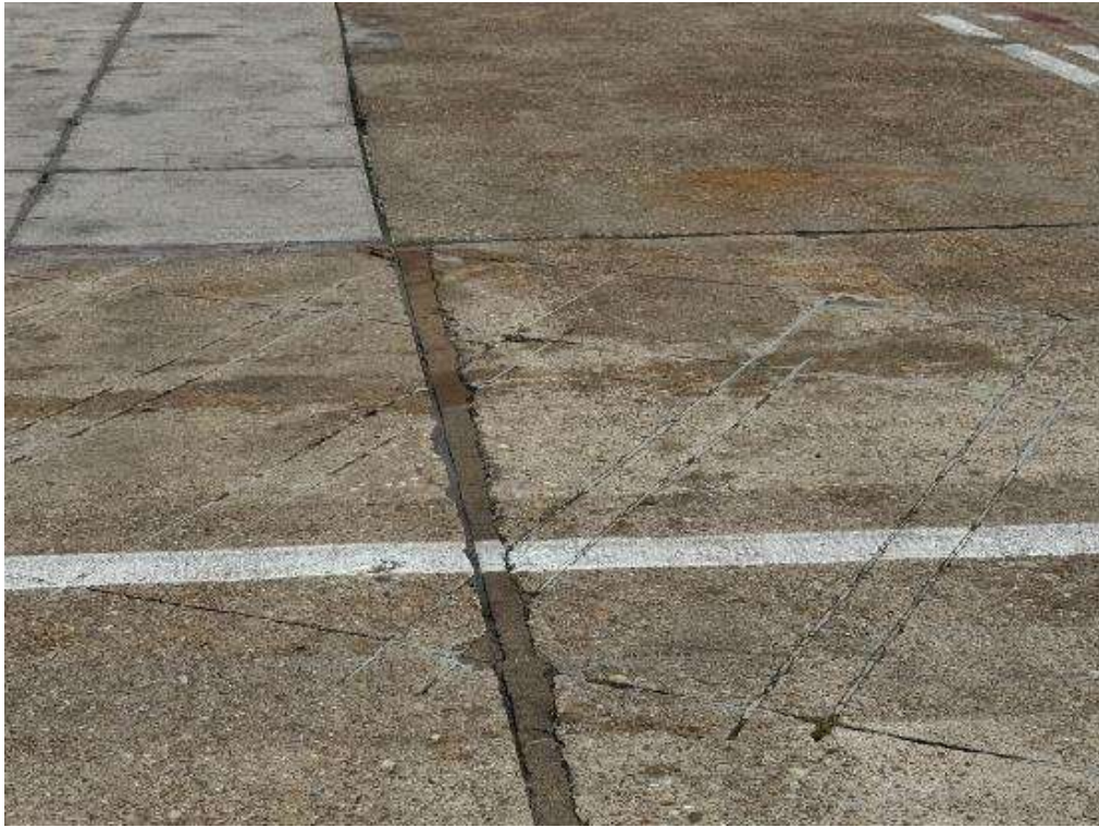
圖 3.9 空側停機坪使用及管線埋設痕跡
