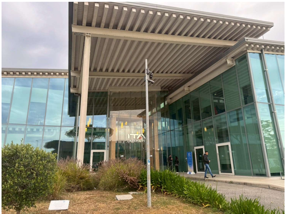
圖 2.13 與羅馬機場公司辦公大樓共構之義大利航空辦公大樓
