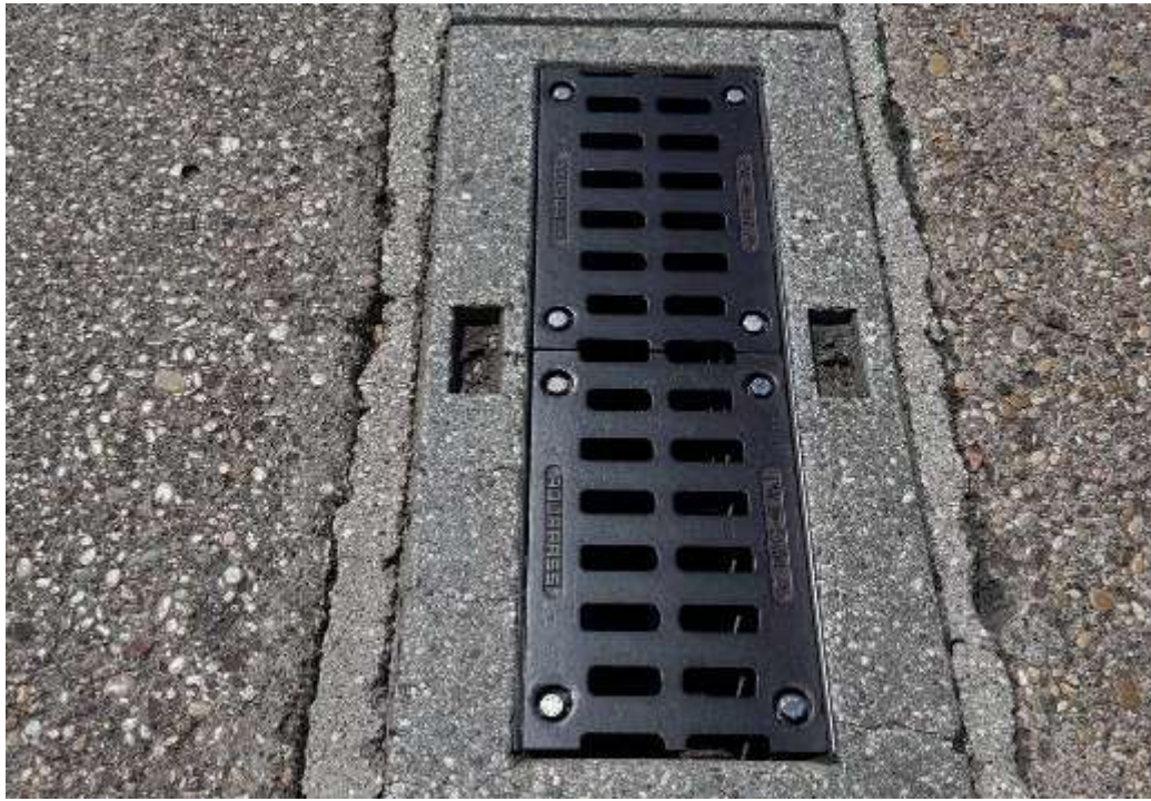
圖 3.5 空側勤務道路上之排水溝
