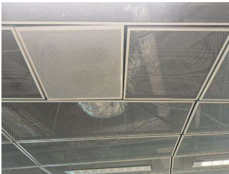
圖 4.45 天花板採簍空洞洞板設計
