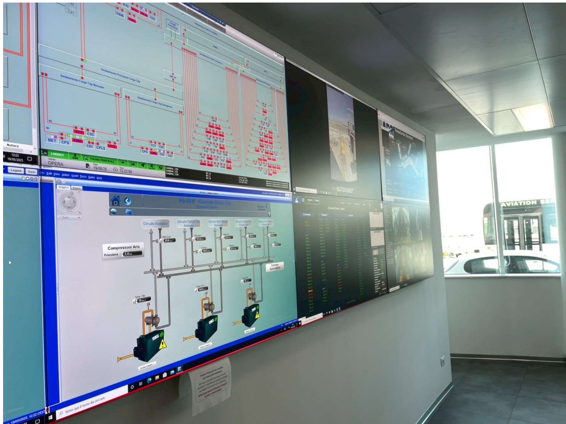
圖 2.9 空調系統監控
