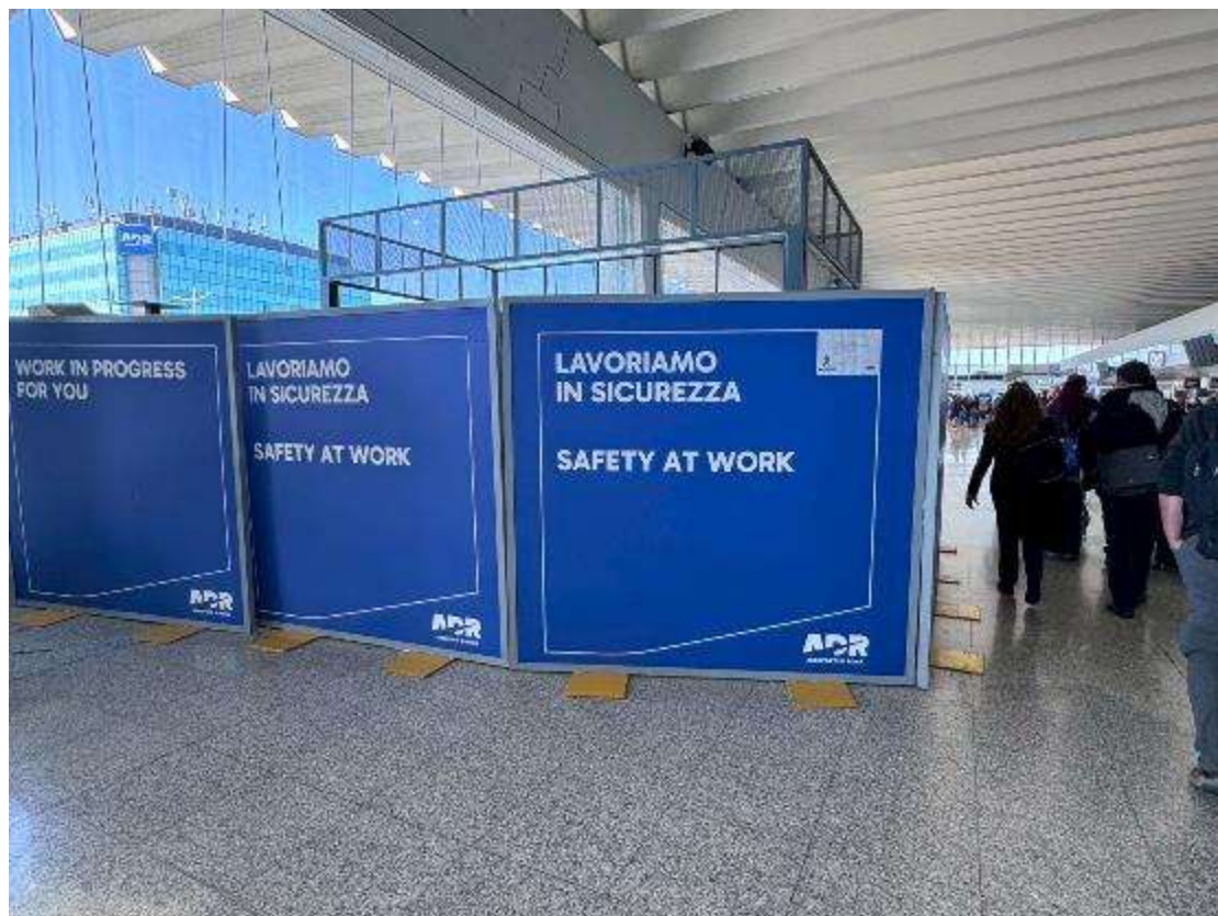
圖 4.20 現場施工圍籬
