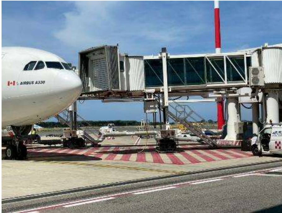
圖 3.25 羅馬機場空橋
