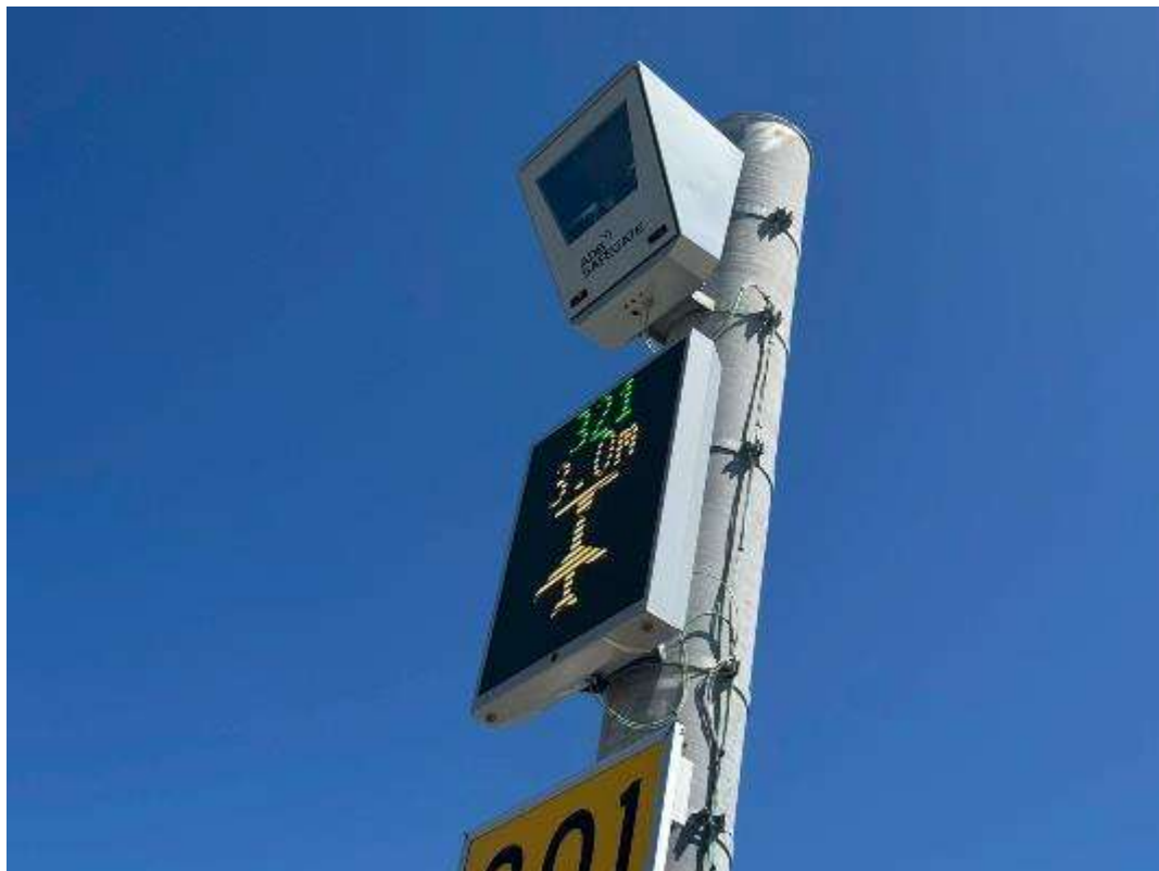
圖 3.32 第二代先進目視導引系統進場畫面
