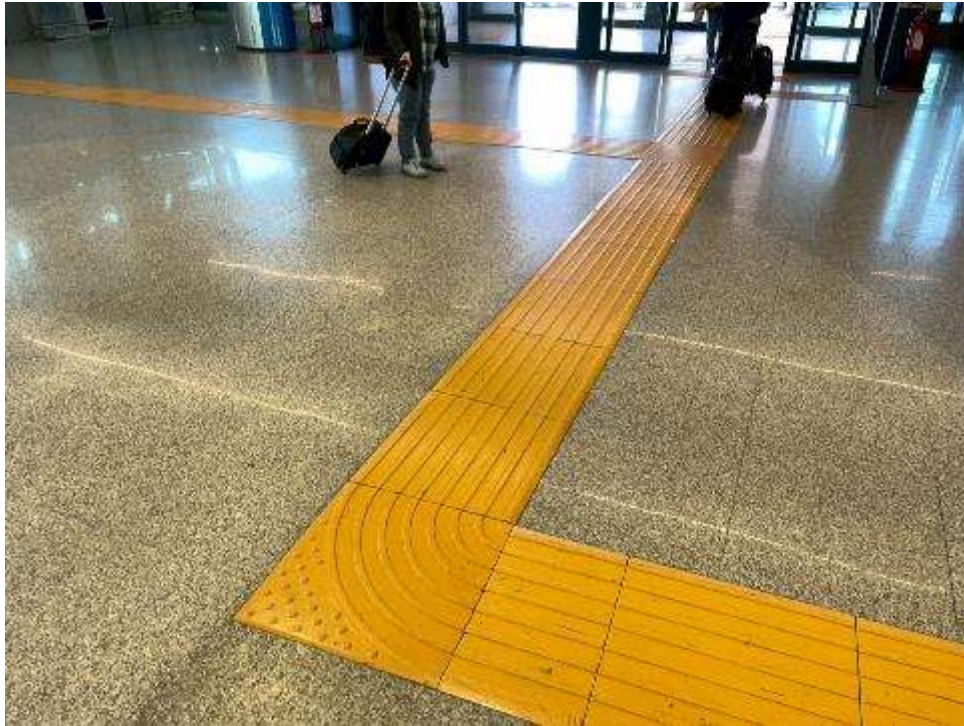
圖 4.58 航廈內設置導盲磚
