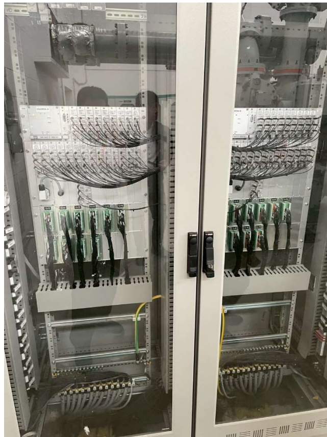
圖 5.6 電力監控系統盤體
