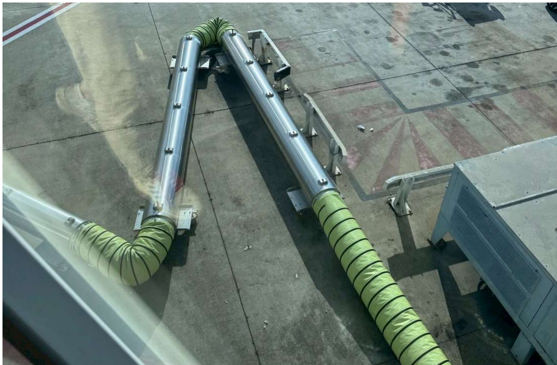
圖 3.28 橋氣採鋼管連接方式
