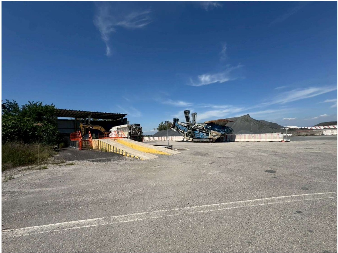
圖 3.22 預拌混凝土廠營造機械
