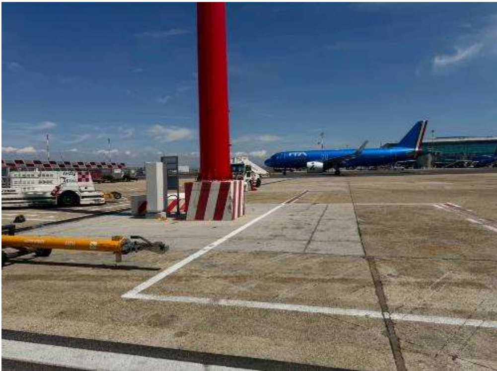
圖 3.12 架高之高桅桿燈水泥墩
