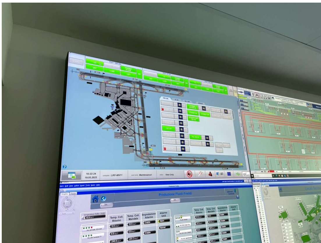
圖 2.6 跑道燈光系統監控
