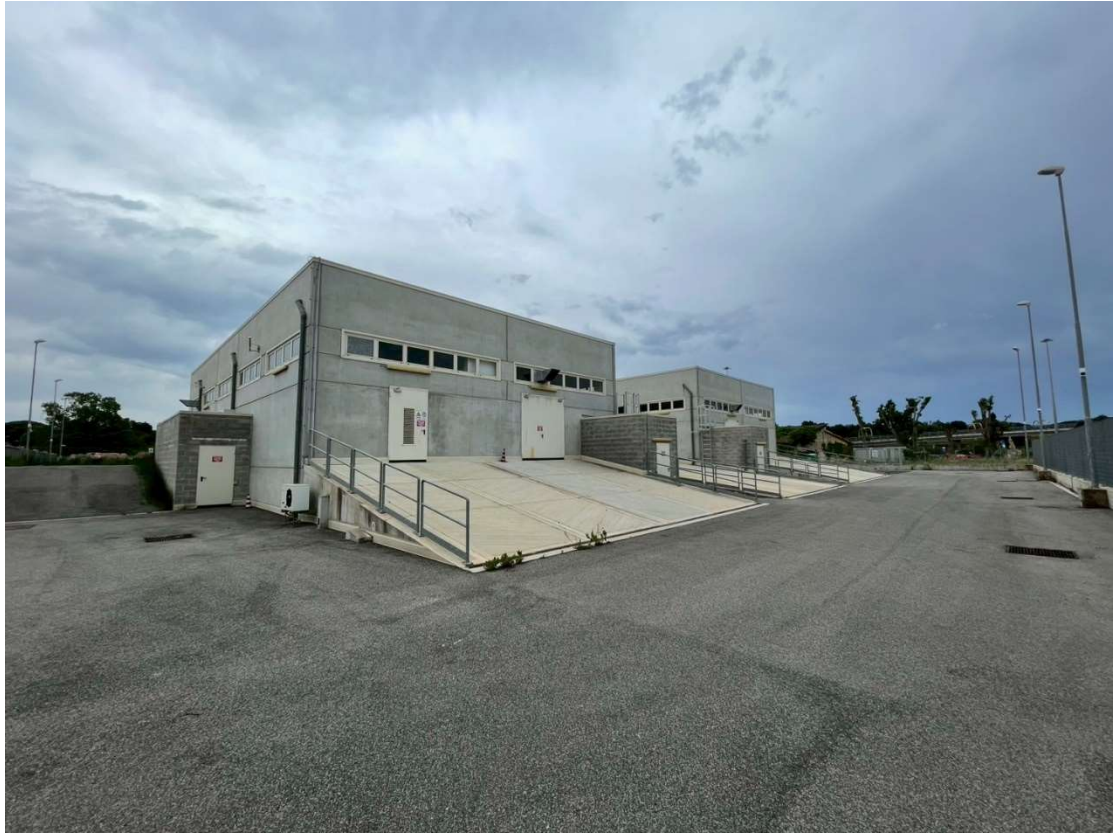
圖 5.1 羅馬機場主變電所
