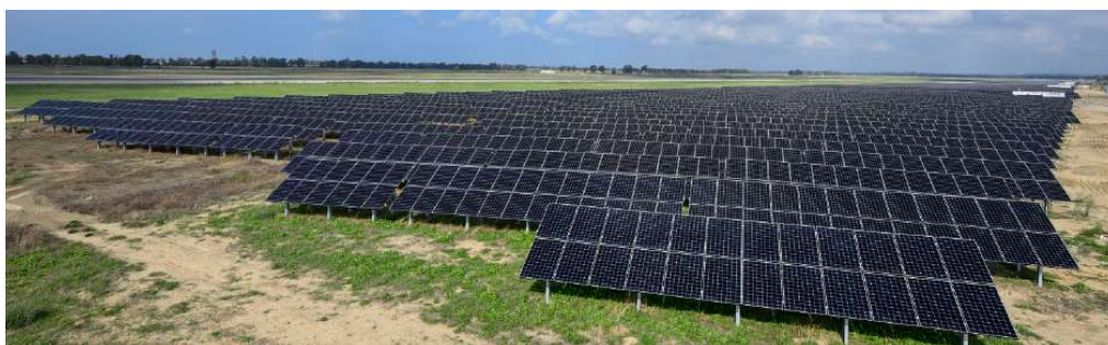
圖 6.4 羅馬機場跑道旁太陽能系統空照圖
