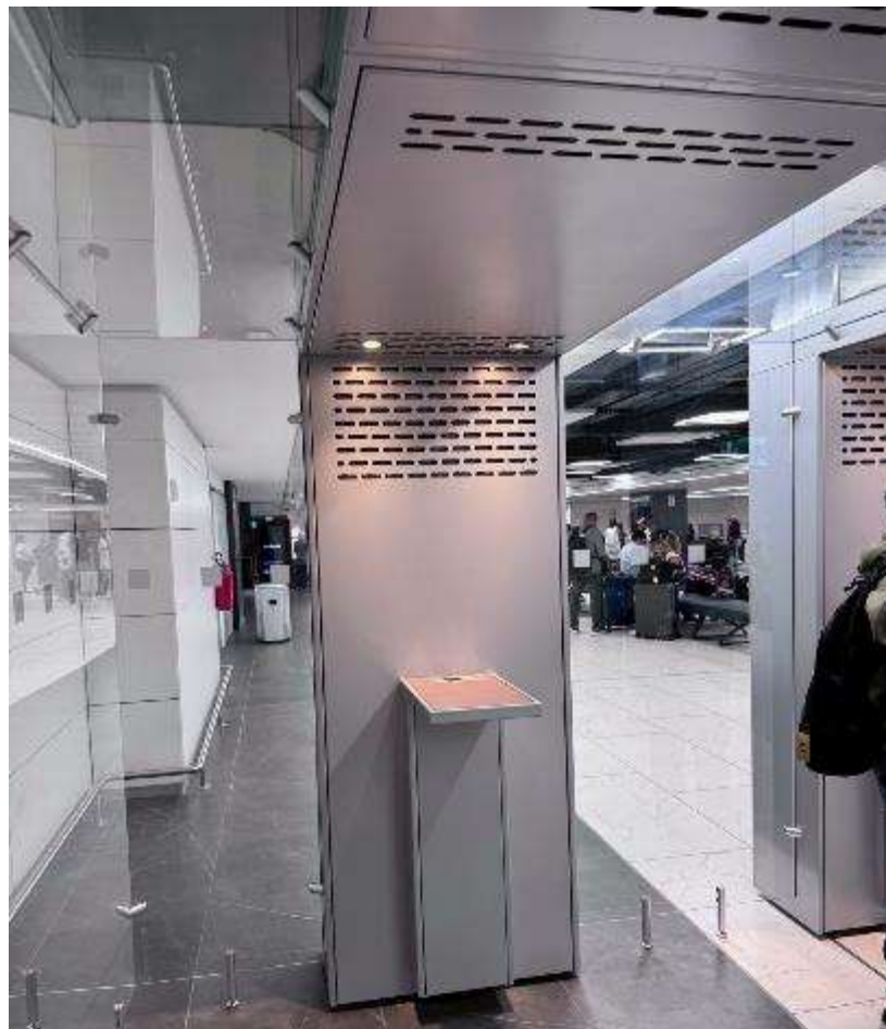
圖 4.23 出境大廳多處提供書寫桌台並結合出風口
