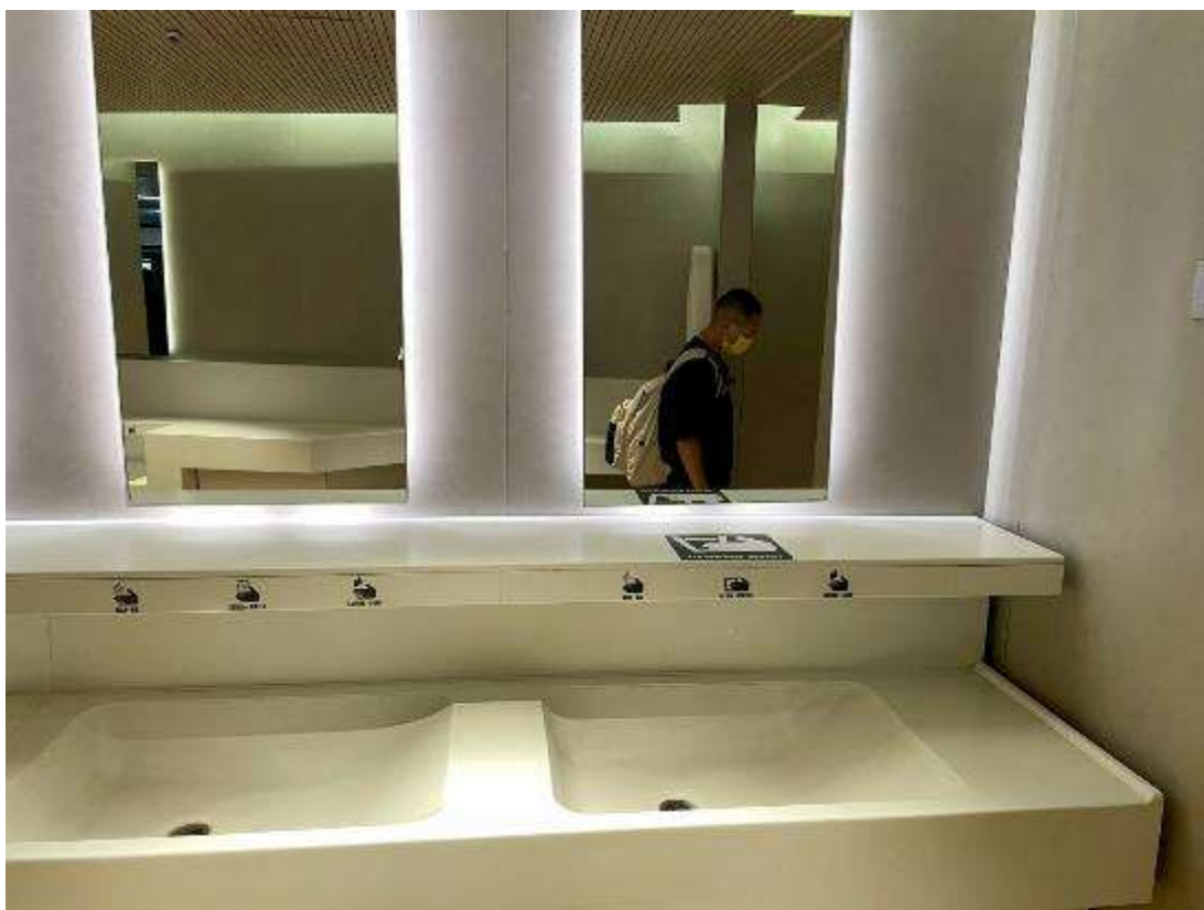
圖 4.67 洗手台採三合一配置（水龍頭、給皂機、風乾機）
