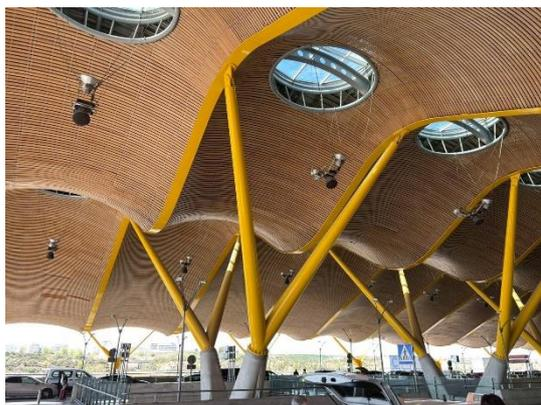
航廈屋頂由許多巨型「Y」字型鋼柱支撐，屋頂則設計了眾多圓型玻璃天窗作為自然光來源，高低起伏的天花彷彿綿延山脈，採用經過防火處理的一根根長條竹片裝飾而成，工法繁複且細緻。
