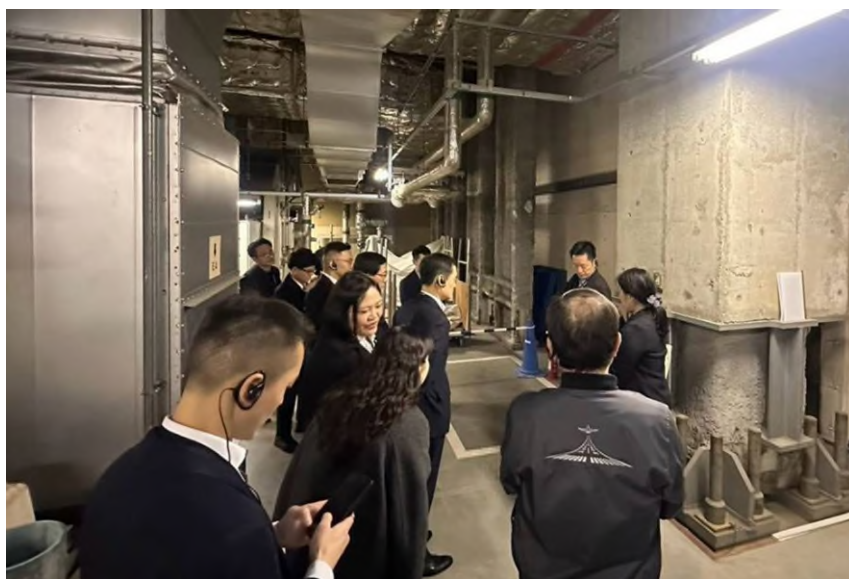
圖 2.1 關西機場第一航廈底部頂升支柱
