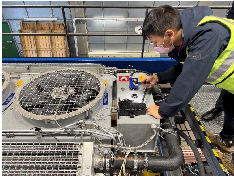
圖 19 確認冷卻液水量
