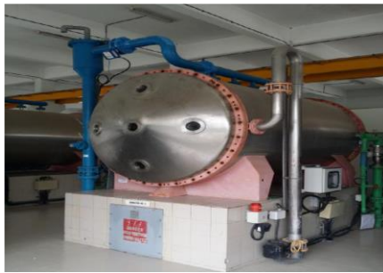
圖 4.8 升級前臭氧產生器現況 圖 4.9 升級 3 個臭氧產生器後現況
