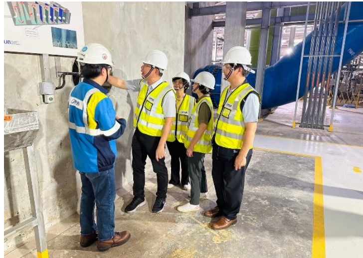
圖 4.14 蔡厝港水廠工程師介紹淨水處理設備功能
