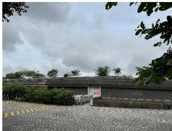
圖 3.2 海水淡化廠地面永續發展展示館
