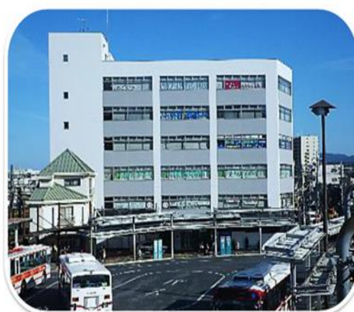
2.テナントビル
