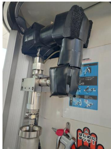
圖 26 芝公園加氫機外觀構造及操作說明
