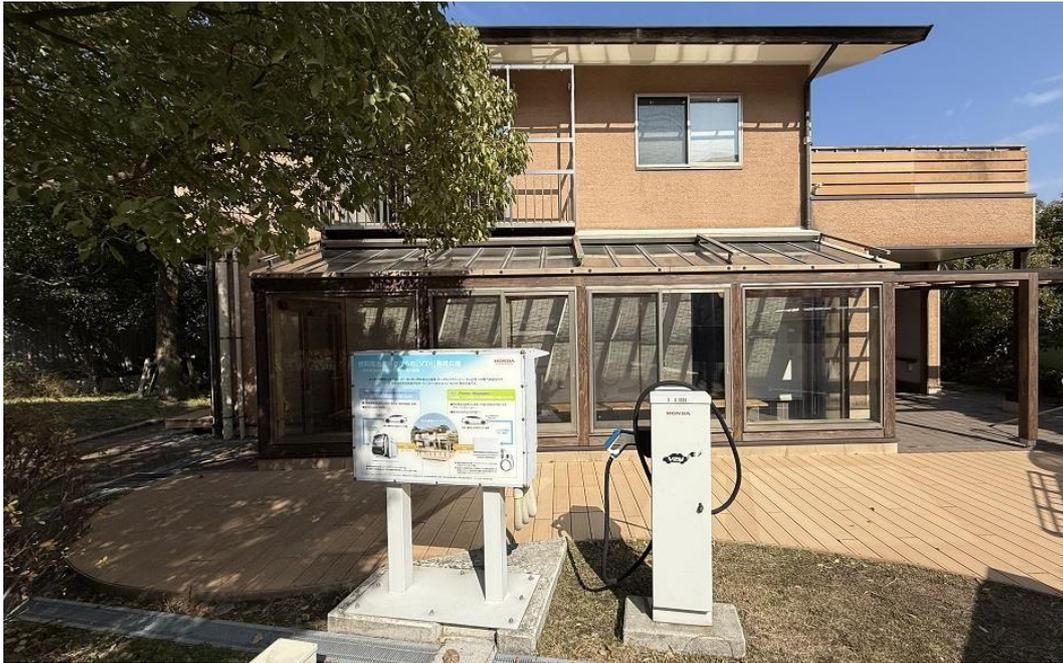
圖 27 燃料電池車用 V2H 電力供應系統設備
