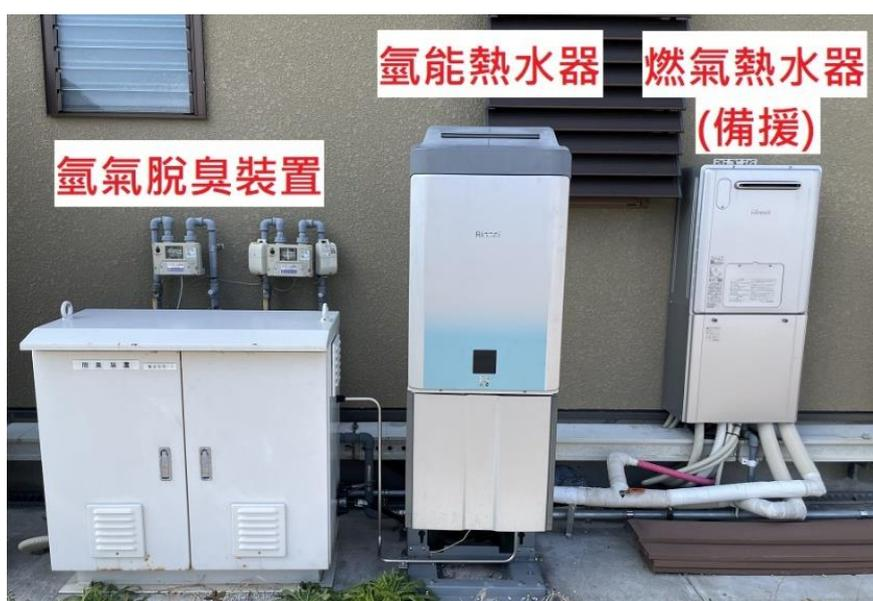
圖 24 林內公司於實證住宅設置的氫能熱水器相關設備
