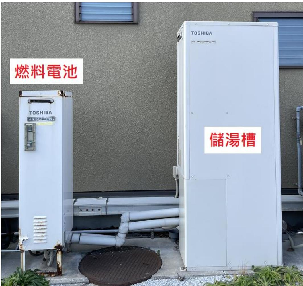
圖 25 住宅用純氫燃料電池熱電聯供系統設備
