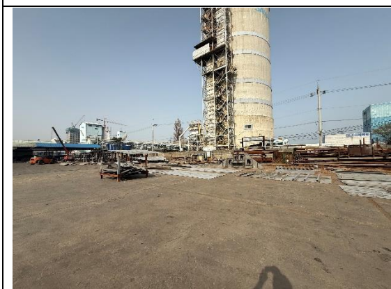
小組件焊接區
