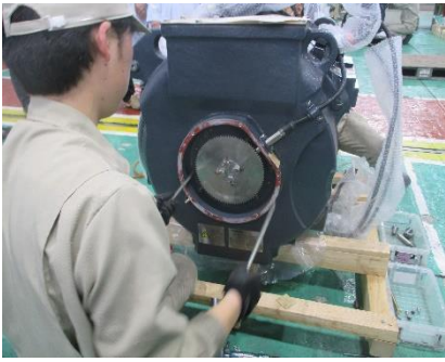
圖 4-6-2-13 拆除定位長螺栓
