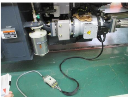
圖 5-3-6 油泵外接 440VAC
