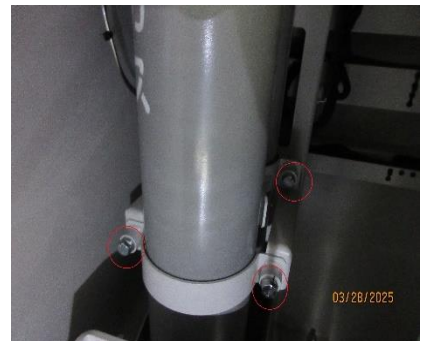
圖 4-7-2-6 固定鋼瓶底座螺栓
