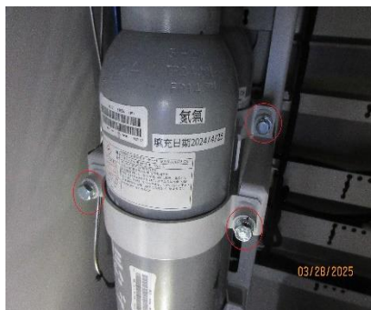
圖 4-7-2-5 固定鋼瓶的螺栓
