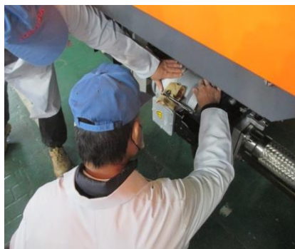
圖 4-5-2-1 檢查油泵運轉狀態
