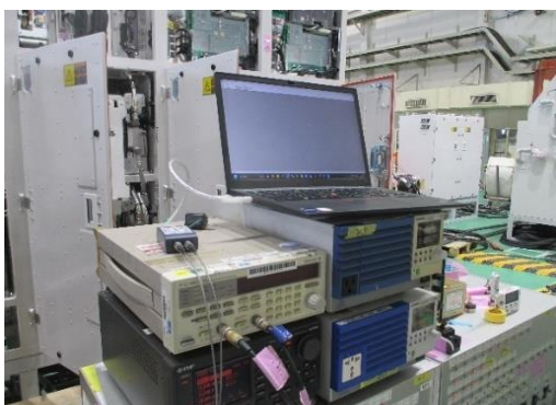
圖 4-1-3-21 模擬監控設備(1)
