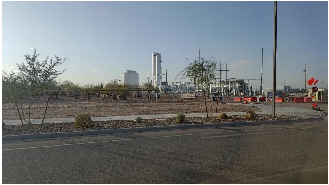
圖 38 台積電美國廠 Fab21 西側之氣體廠
