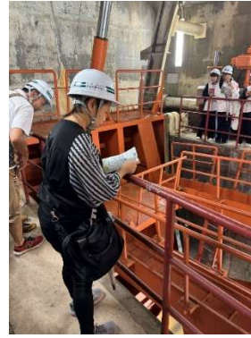
壩體基礎檢查廊道
