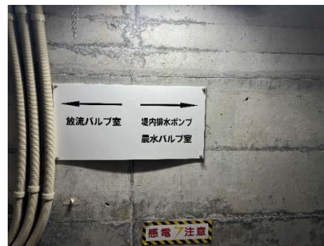
壩體基礎檢查廊道
