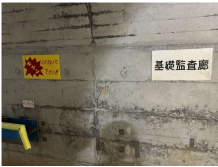
壩體基礎檢查廊道 1
