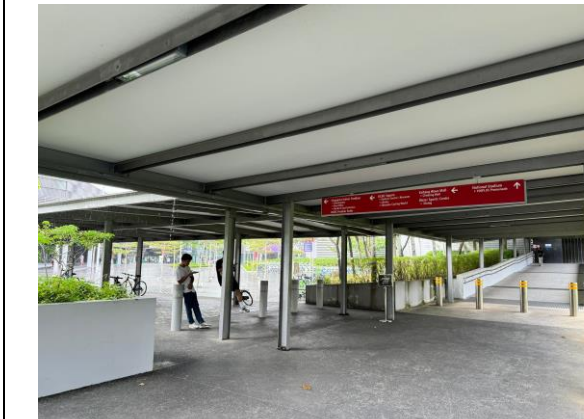
公車接駁站風雨走廊
