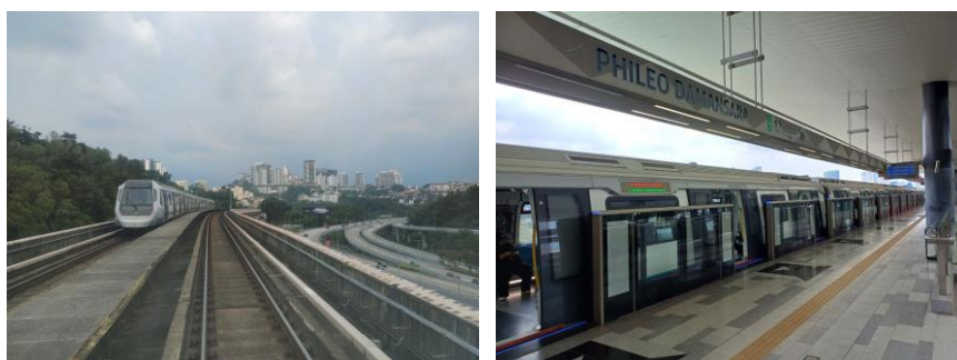
圖 28 捷運高架路段
