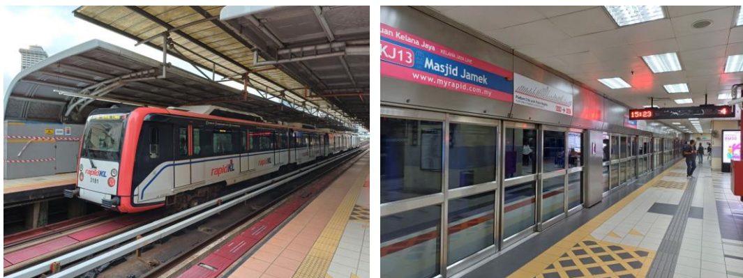
圖 21 輕軌高架車站及地下車站
