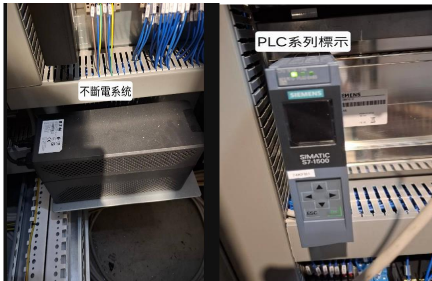
圖 19 不斷電系統(左)與可程式控制器 (右)
