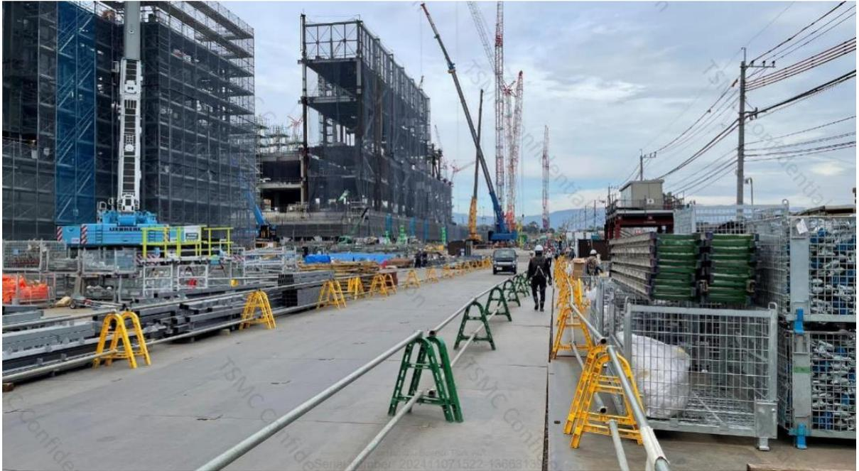
圖 12、JASM 工區顏色管理照片(資料來源：tsmc 提供)
