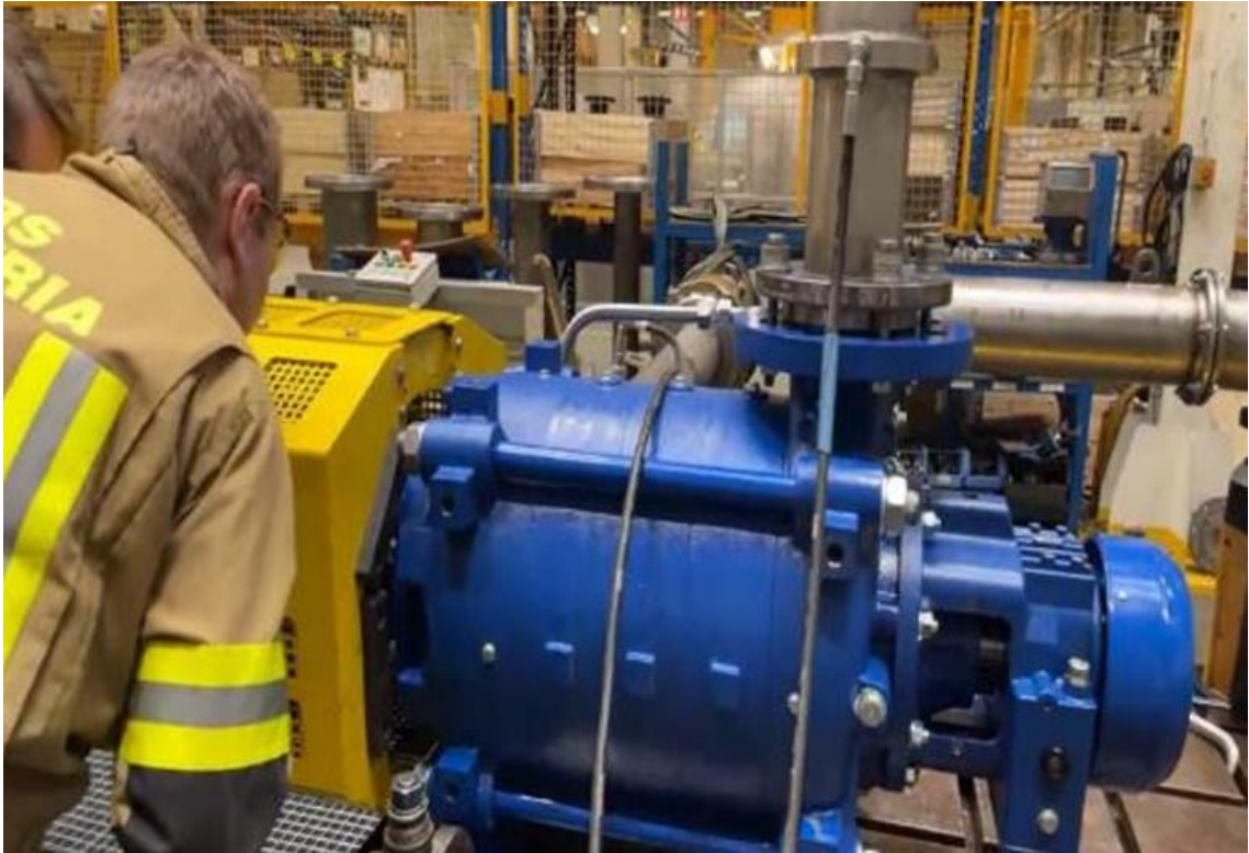
圖 6 檢視馬達與泵浦連結情形
