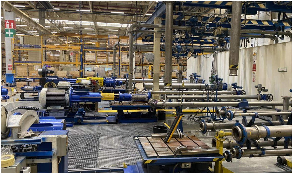
圖 4 波蘭泵浦工廠高壓泵浦設備
