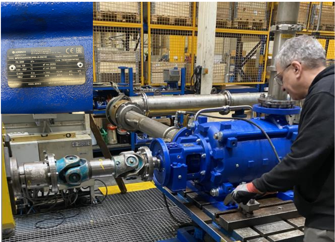
圖 5 確認高壓泵浦設備規格
