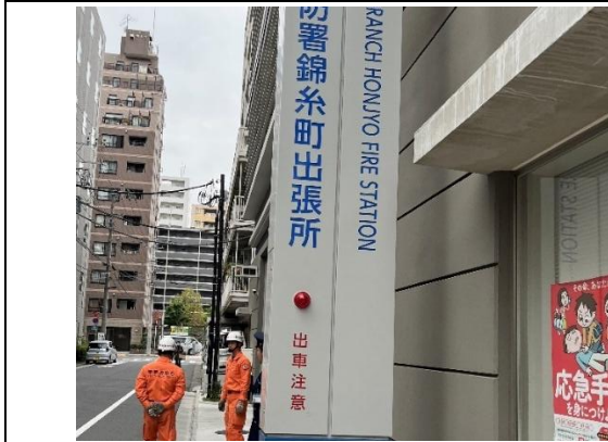
圖 87、車庫旁出車警示裝置
