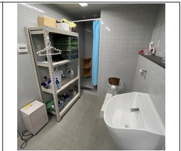
圖 71、1 樓右側除汙室(2)
