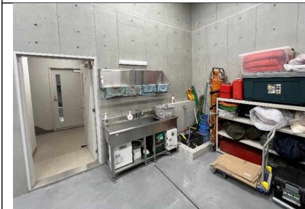
圖 72、1 樓左側清洗設備
