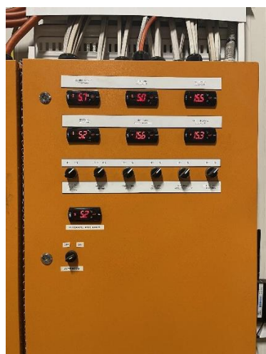
圖 1. Lynch group 公司切花作業區的溫度控制面板，依進貨區、理貨區、包裝區、出貨區等設定不同溫度以維持切花鮮度。
