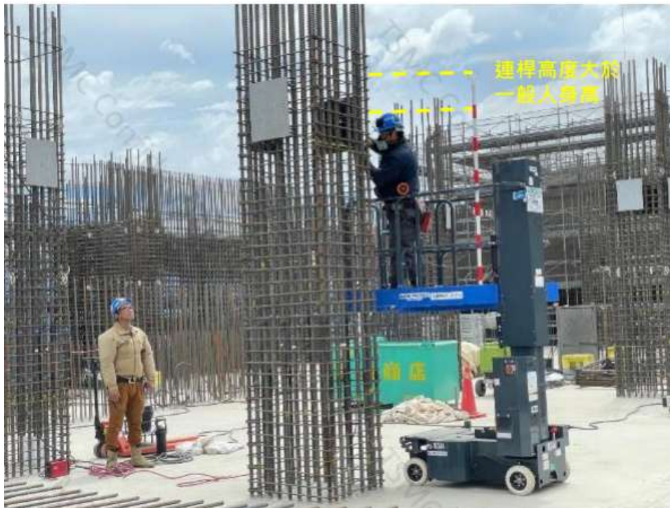
圖 17、JASM 工區高空工作車設置防碰撞連桿照片 (資料來源：tsmc 提供)
