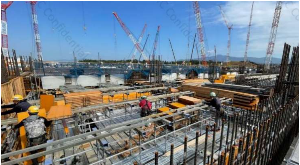
圖 16、JASM 工區模板組立現場照片 (資料來源：tsmc 提供)
