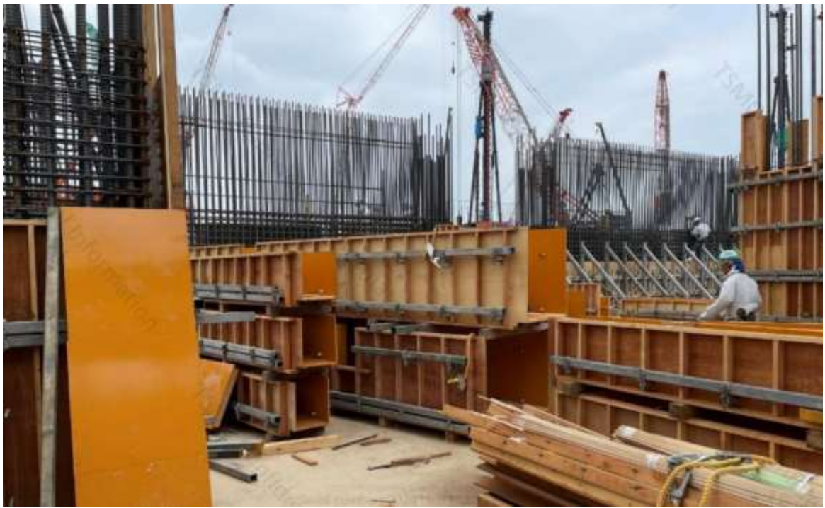
圖 14、JASM 工區樑模地面預組照片(資料來源：tsmc 提供)
