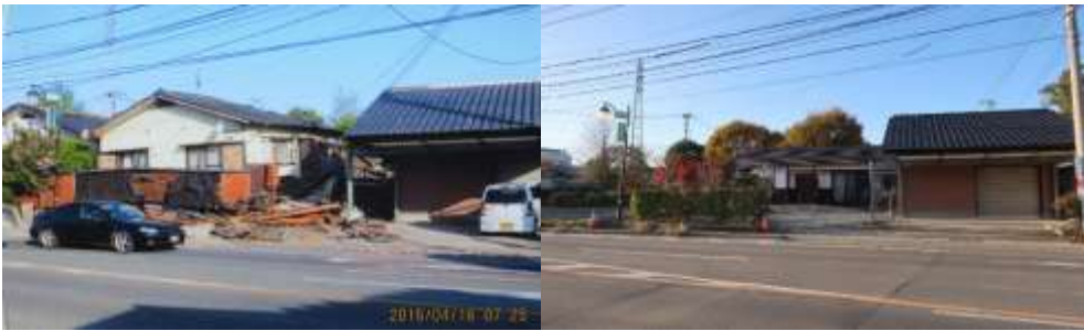
圖 3、熊本縣內受損建物重建照片(資料來源：熊本數位檔案館)
