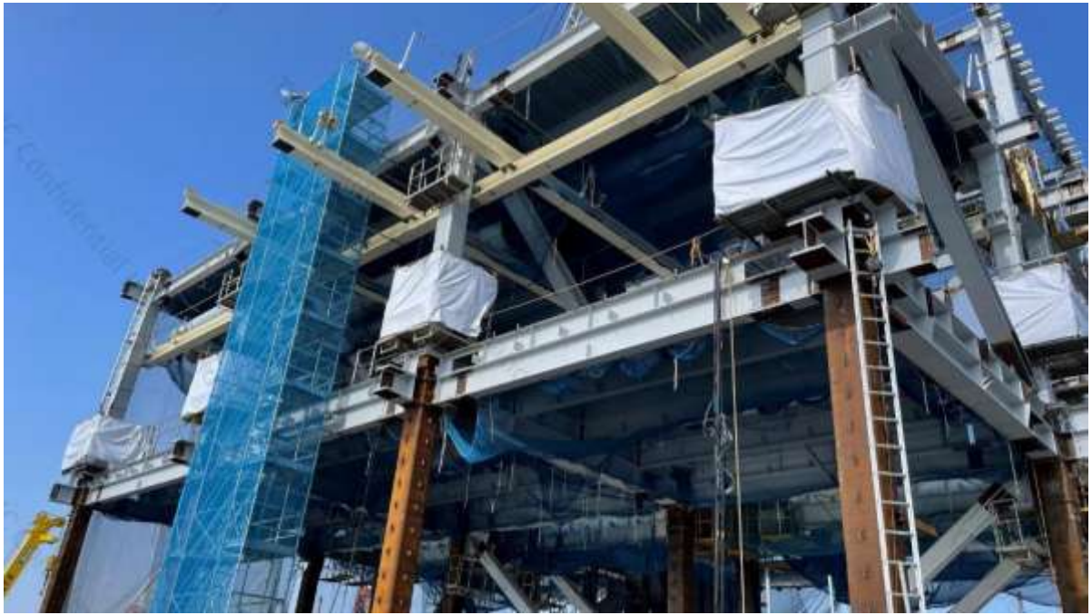
圖 15、JASM 工區鋼構組裝階段現場照片 (資料來源：tsmc 提供)
