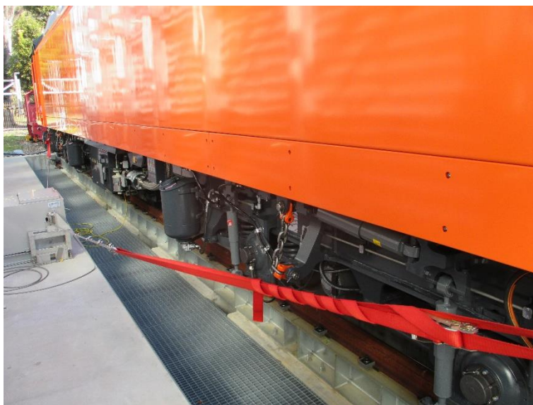
圖3-8、絞盤纜線固定狀況
