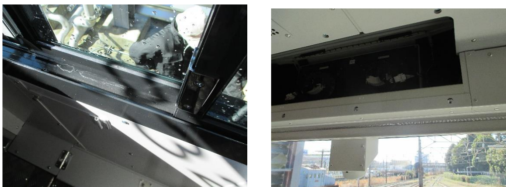
圖 3-11、窗溝與天花板檢查是否滲水
