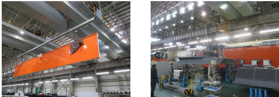
圖 6-3、吊掛作業保持水平
