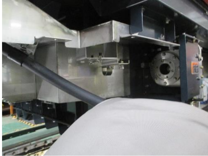
圖3-17、高壓穿套內部檢查
