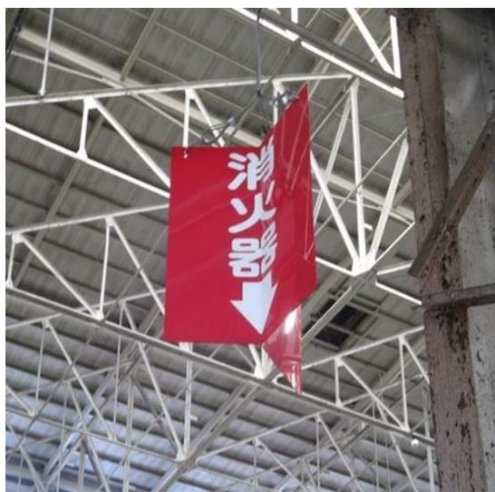
圖 5-1-2 滅火器指示牌三平面立體構造
