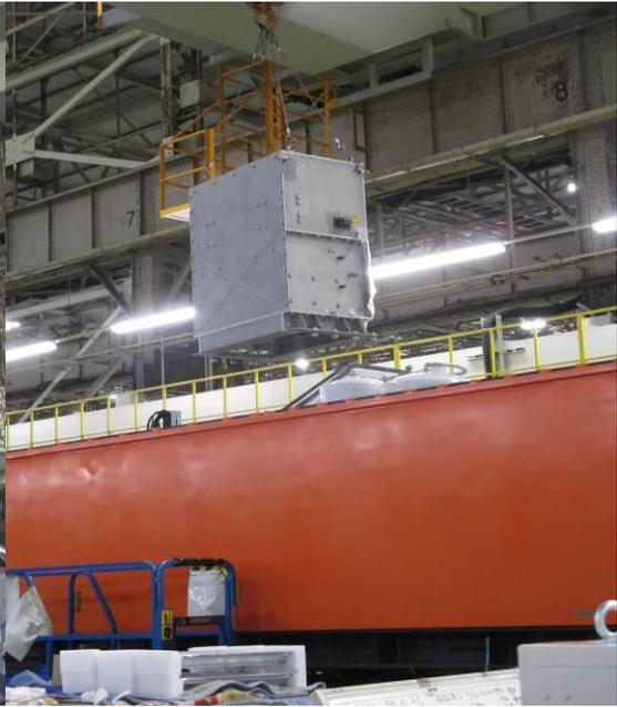
圖 3-1-8 C 工程 組合式冷卻塔吊掛組裝作業
