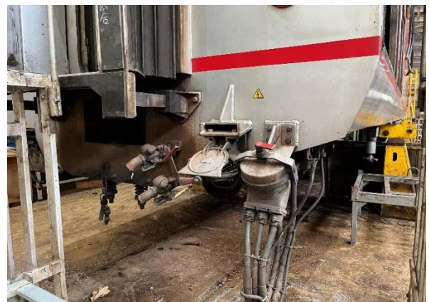
圖 6-2-7 PP 機車跨接電纜
