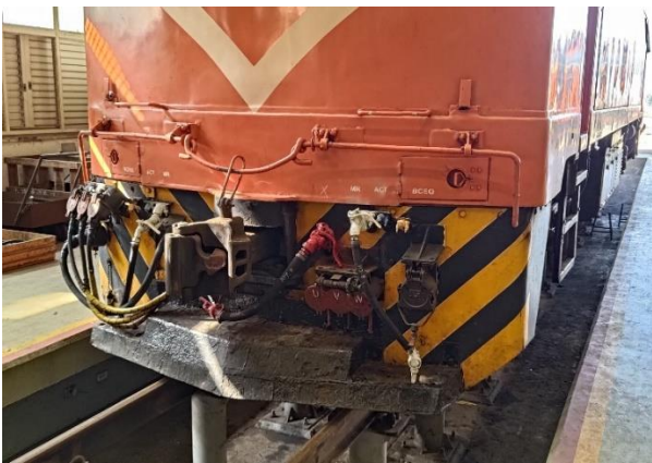
圖 6-2-6 GE 機車跨接電纜
