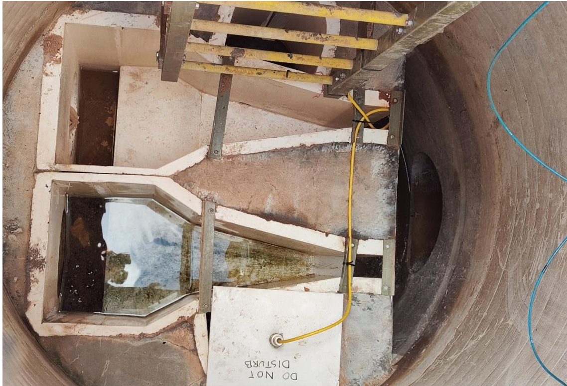
圖 42 參觀馬齒水庫自動滲流流量監測設備現勘
