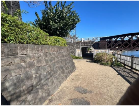
圖 65 仿照城牆砌石工法
