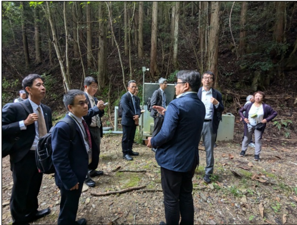
圖 77 黑土川小水力發電公司向考察團介紹取水設施
