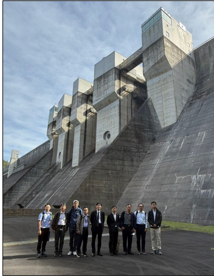
圖 9 現勘日吉水壩之和影
