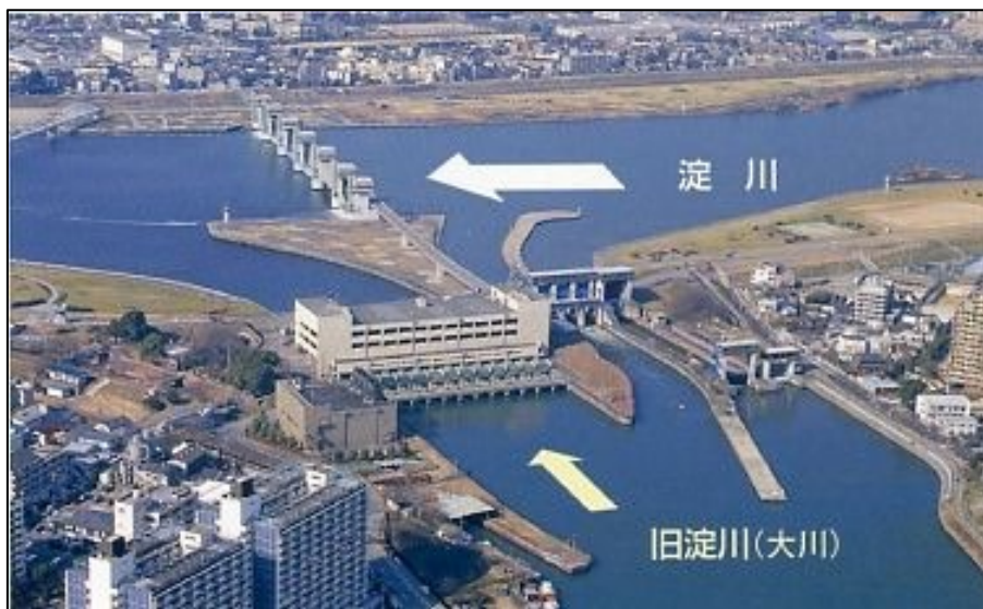
圖 43 防潮水門及毛馬排水泵站
