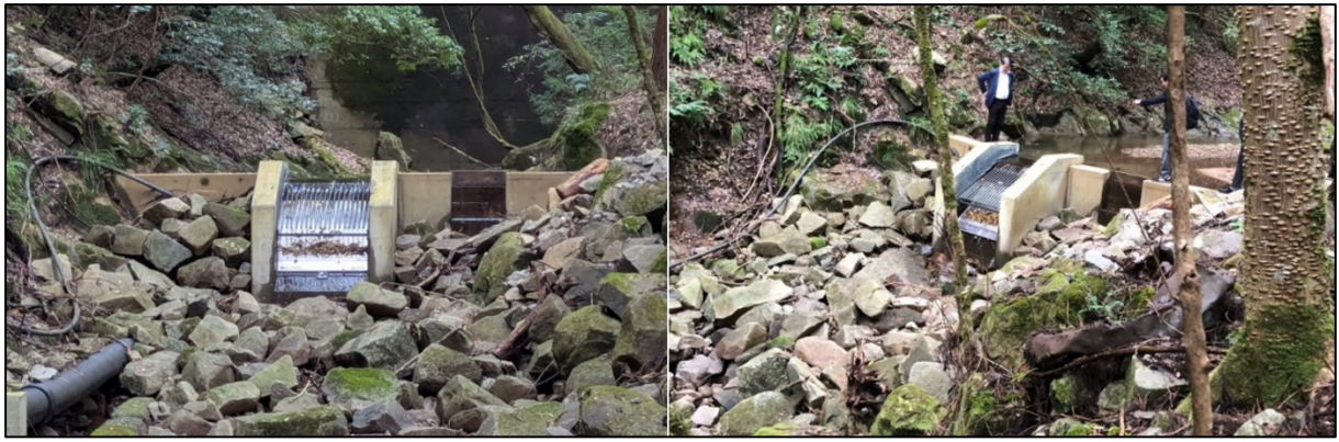
圖 80 取水堰位置利用原有農業取水設施考察照片
