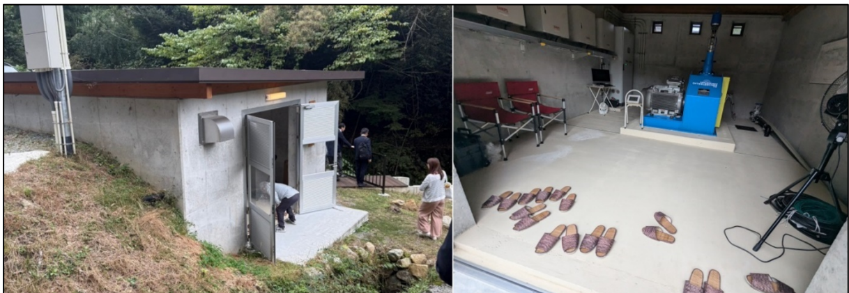
圖 86 黑土川小水力發電廠發電機房考察照片
