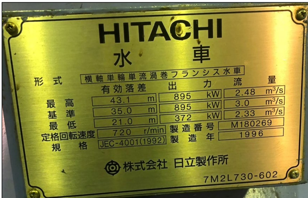
圖 98 日吉水壩水車設備名牌
