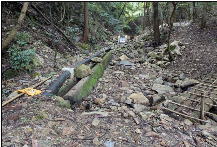
圖 81 壓力管線沿山腳下地形鋪設考察照片
