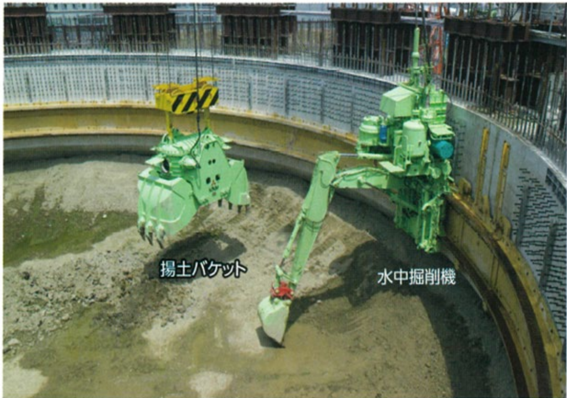
圖 65 立坑挖掘機現場挖掘
