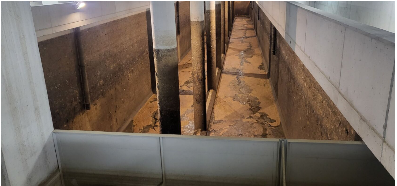
圖 6、ETXEBARRI STORMWATER 調節池
