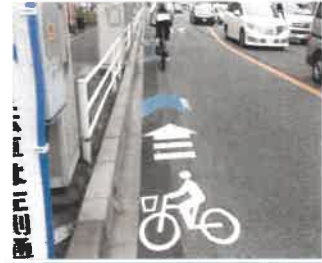
車道混在 ※ (矢羽根型路面表示)
