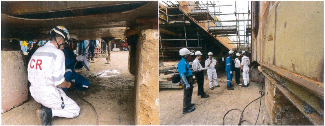
1131219 上午 泥艙段與右艙段組合後 CR 驗船師檢查
