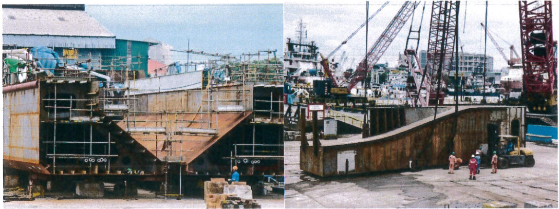
1131218 泥艙段 + 右艙段吊裝組合中
